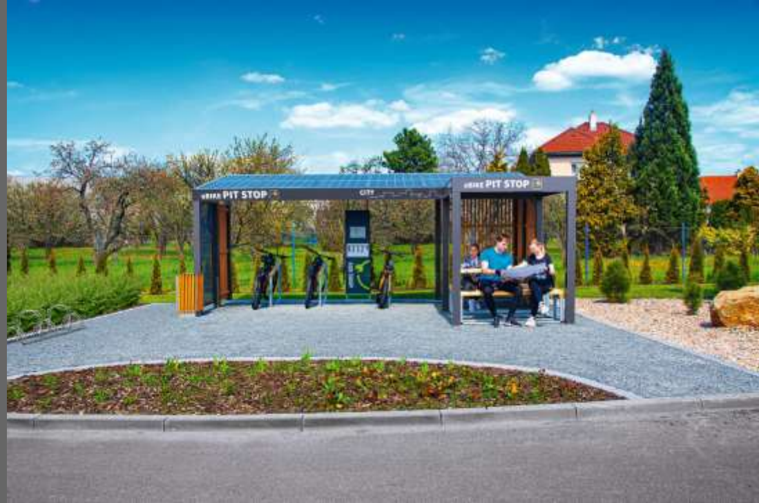
Stazione con pannelli fotovoltaici separati dalla stazione installati su una tettoia, con cavi di ricarica con spine dedicate.
