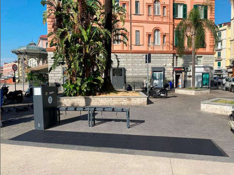
Stazione con pannelli fotovoltaici separati dalla stazione, con cavi di ricarica con spine dedicate.
