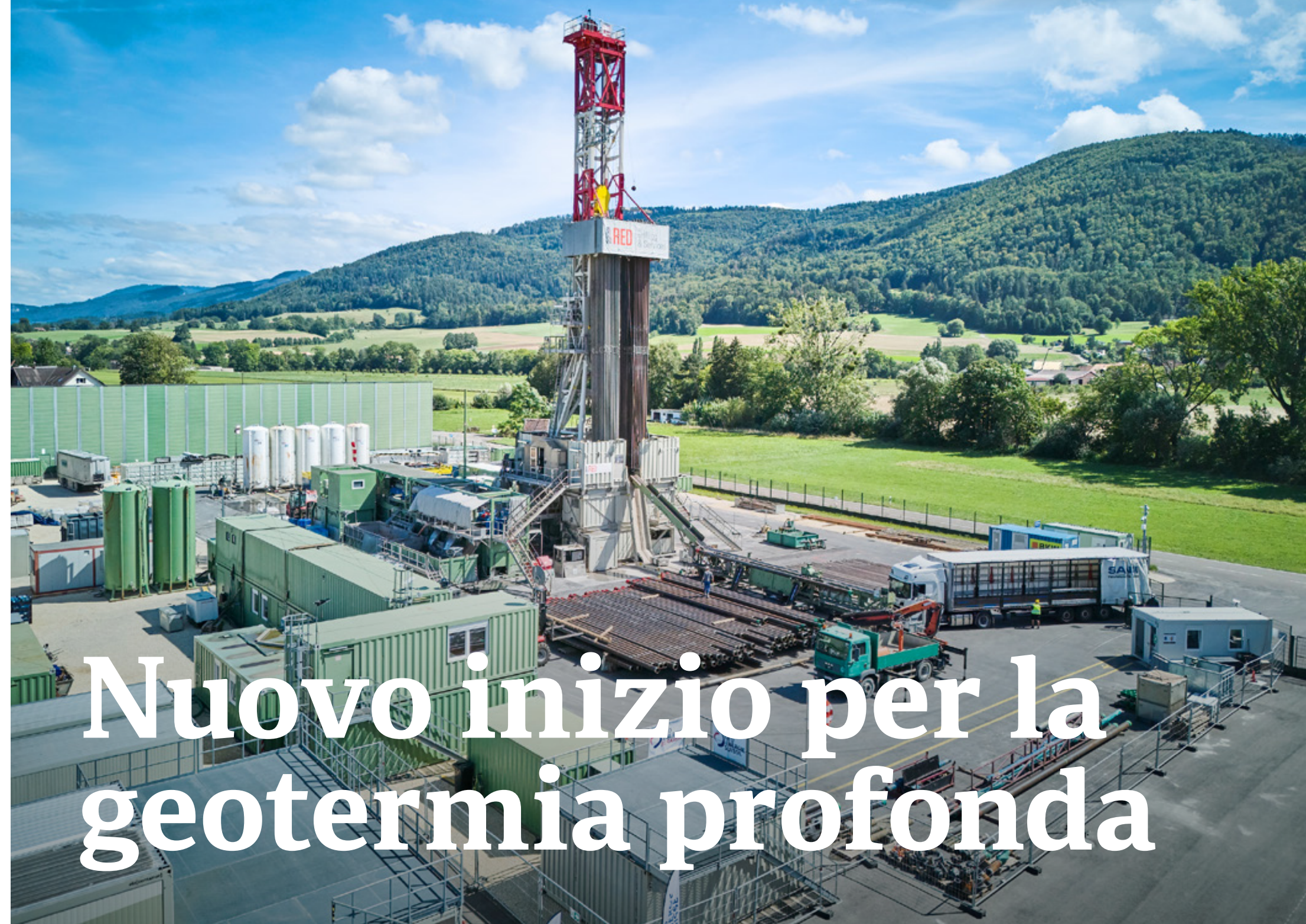
Il sito di trivellazione per la geotermia di Haute-Sorne JU sembra un grande cantiere.
