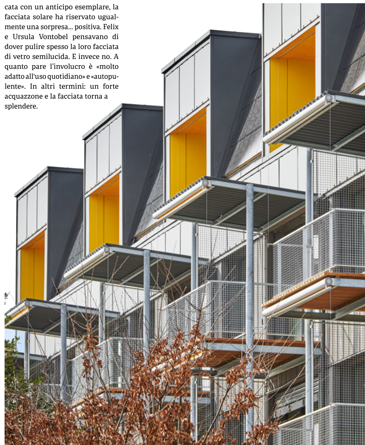
Con la facciata FV della «Maison Climat» di Bienne sono stati ottimizzati costi e benefici. (Foto: Damian Poffet)
