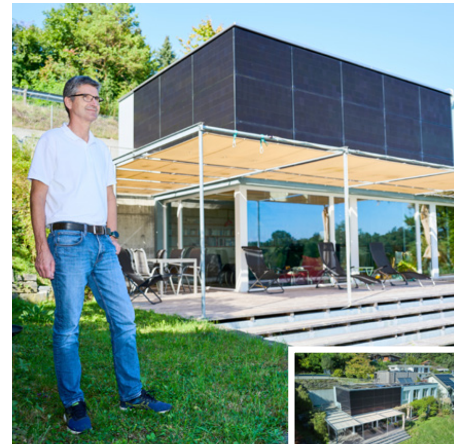
Jürg Beriger ha rivestito con pannelli FV la parte priva di finestre della sua casa a Lostorf SO.
