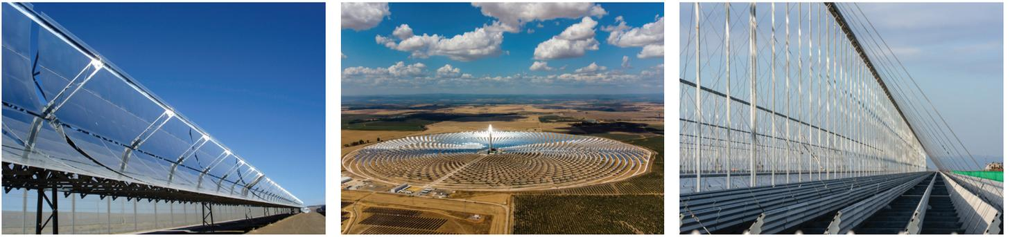
Tre tipi di centrale elettrica a concentrazione solare (in inglese: Concentrated Solar Power/CSP): collettori parabolici con riflettore e tubo assorbitore (a sinistra); centrale elettrica a torre solare con eliostati e torre centrale con assorbitore (centro); collettori Fresnel costituiti da specchi lineari, specchi secondari e tubi assorbenti (a destra). Foto: Shutterstock
