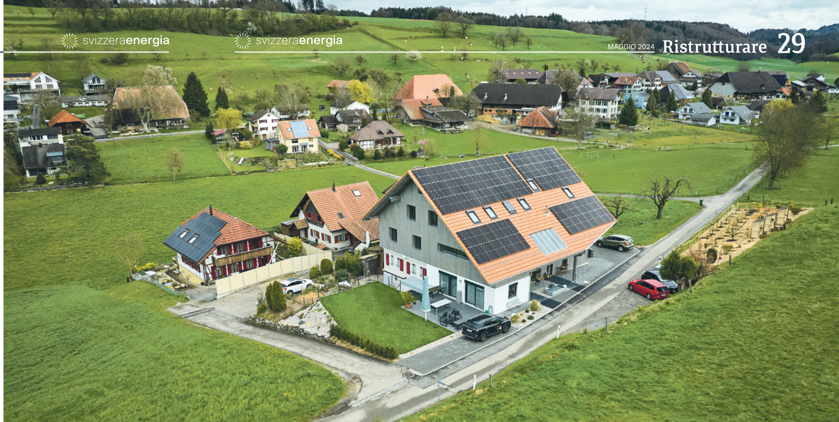
Il tetto spiovente esposto a sud ospita un impianto fotovoltaico: la sua potenza massima è di 30 chilowatt.
