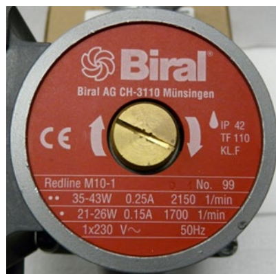
Figura 2: targhetta pompa. Fonte: Biral Redline M10-1
