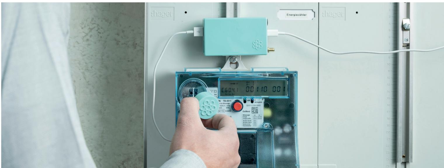
**Figura 2:** L'app riceve i dati del consumo di energia elettrica in tempo reale grazie a un gateway montato sul contatore elettrico. I gateway sono gratuiti per i clienti «cleverStrom». (Immagine: ibw)
