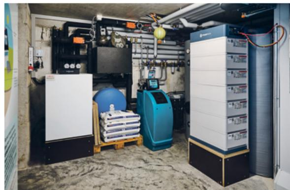
Il locale tecnico è nel piano interrato, dove sono installate pompa di calore e accumulatore di elettricità e di calore.
