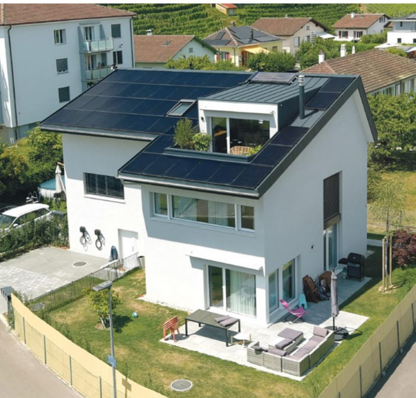
L'elemento che più colpisce della casa di Raphaël Domjan è la forma asimmetrica del tetto, che ha reso possibile una disposizione ottimale dei moduli solari.
