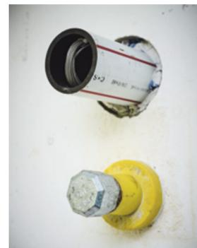
L'allacciamento del gas chiuso (sotto) e la linea di alimentazione predisposta per la stazione di ricarica elettrica.
