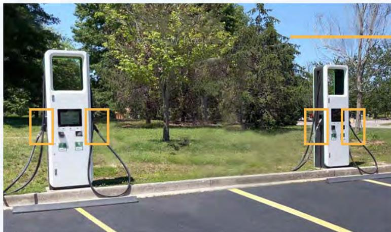
**2 + 2 punti di ricarica:** una struttura in cui è possibile ricaricare un veicolo. Una stazione di ricarica può alimentare più punti di ricarica con diversi connettori.
