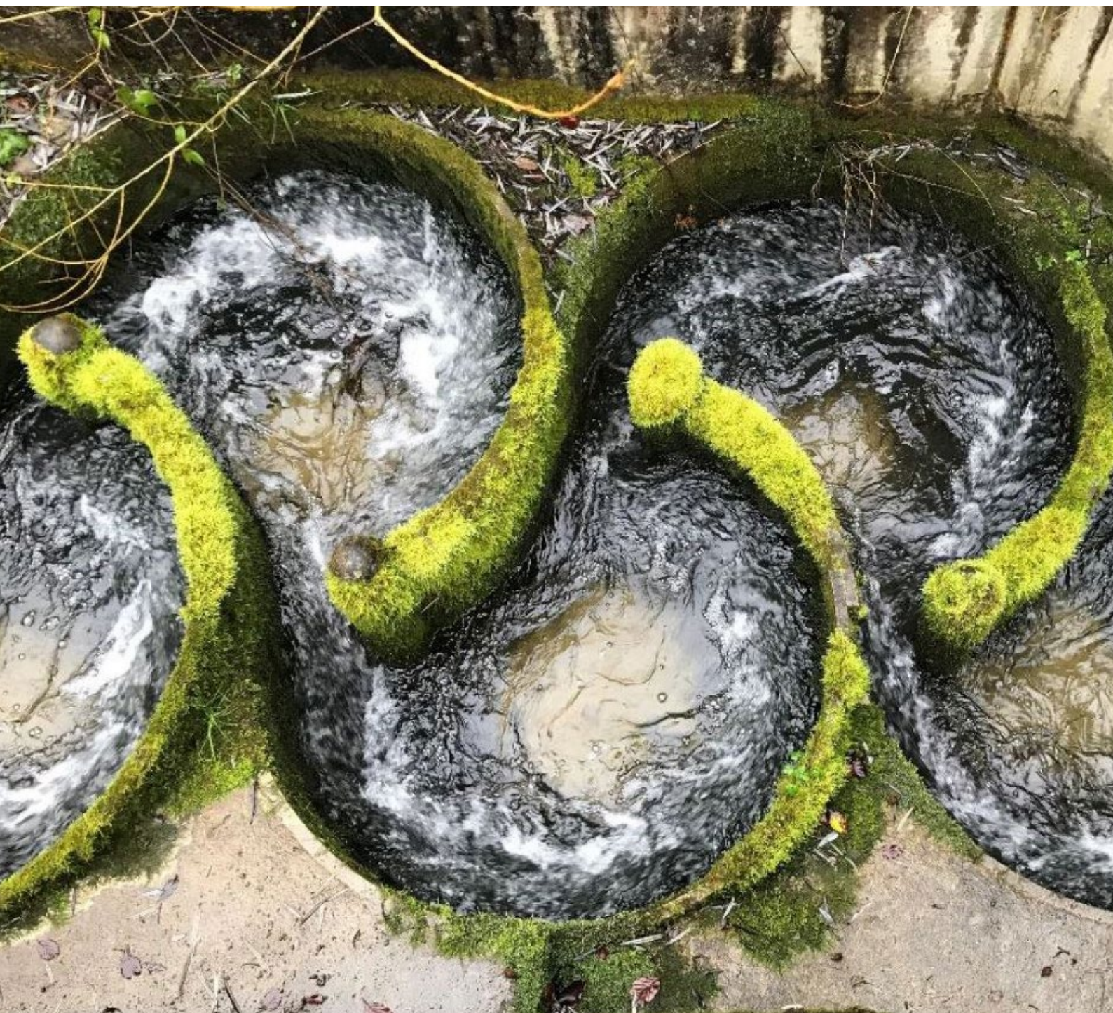
Uscita del passaggio piscicolo a bacino circolare (Foto: IUB/Fischwerk)
