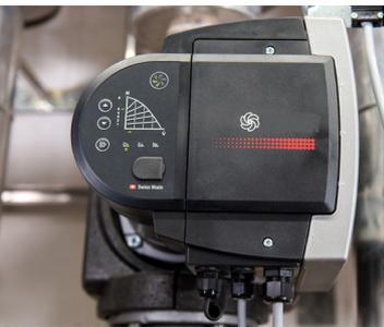
I nuovi circolatori permettono di impostare la portata volumetrica mediante varie funzioni (ad es. automatica, con linea caratteristica di pressione proporzionale o con una regolazione a pressione costante). Di norma questi circolatori sono forniti di fabbrica impostati su «automatico». Con questa impostazione il circolatore
