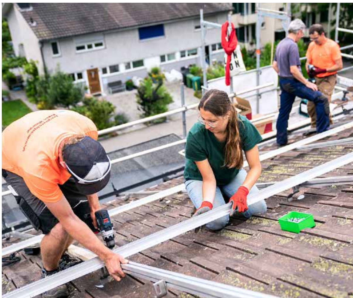
I capicantiere con la maglietta arancione sono responsabili dell'istruzione, della sicurezza e dei lavori più complessi.
