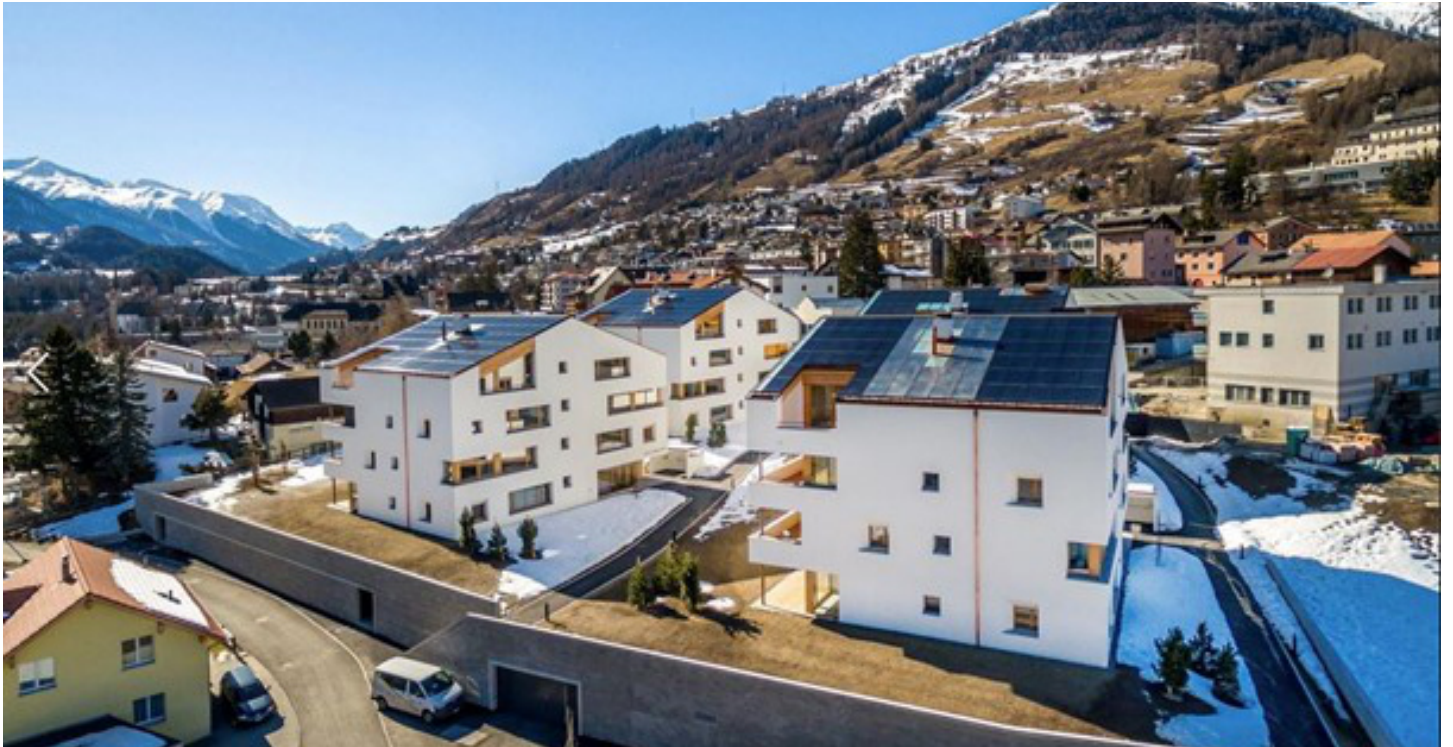
La surbajegiada da monolit a Scuol consista da quatter chasas; trais èn vegnidas cumpigliadas en il project da l'UFE: davant sanester chasa A, cun in spir implant da PV, davostiers chasa B cun moduls da PVT. Davant dretg chasa C: il tetg è muni en il center cun collecturs d'aua chauda, d'omadas varts èn accumpagnadas da moduls da PV, cleramain vesaiavel da l'optica differenta. Foto: Fanzun AG
