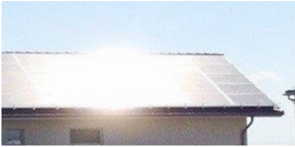
Figura 7: Effetto abbagliante di un tetto inclinato. L'allargamento del fascio di luce è chiaramente visibile, in quanto invece dell'immagine diretta del sole appare una macchia allargata di luce diffusa.
