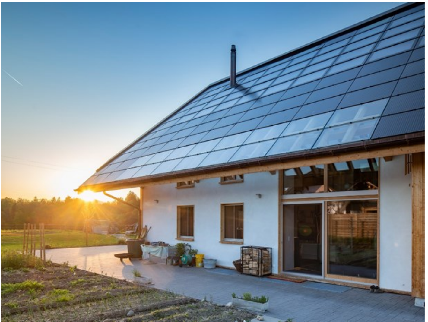
Figura 1: Casa unifamiliare con isolamento in balle di paglia, Graben BE © 3S Solar Plus AG / Premio solare svizzero 2019
