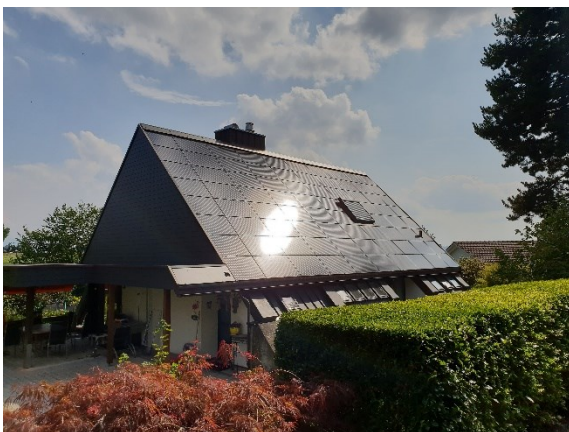
Figura 8: Superficie del tetto prima del risanamento.
