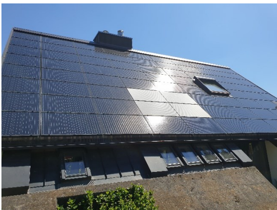
Figura 9: Prova a campione con quattro moduli antiabbagliamento.
