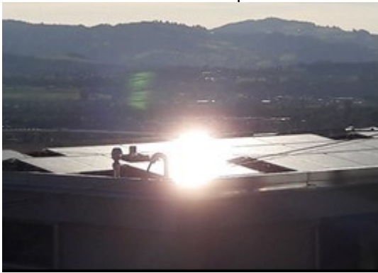
Figura 11: Esempio di effetto abbagliante di un impianto fotovoltaico su un tetto piano. In questo caso, i moduli solari hanno una leggera inclinazione e sono orientati approssimativamente a est rispettivamente a ovest.
