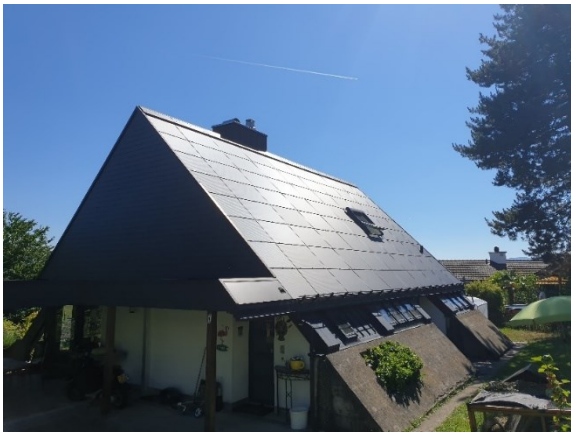
Figura 10: Superficie del tetto dopo la sostituzione dei moduli.
