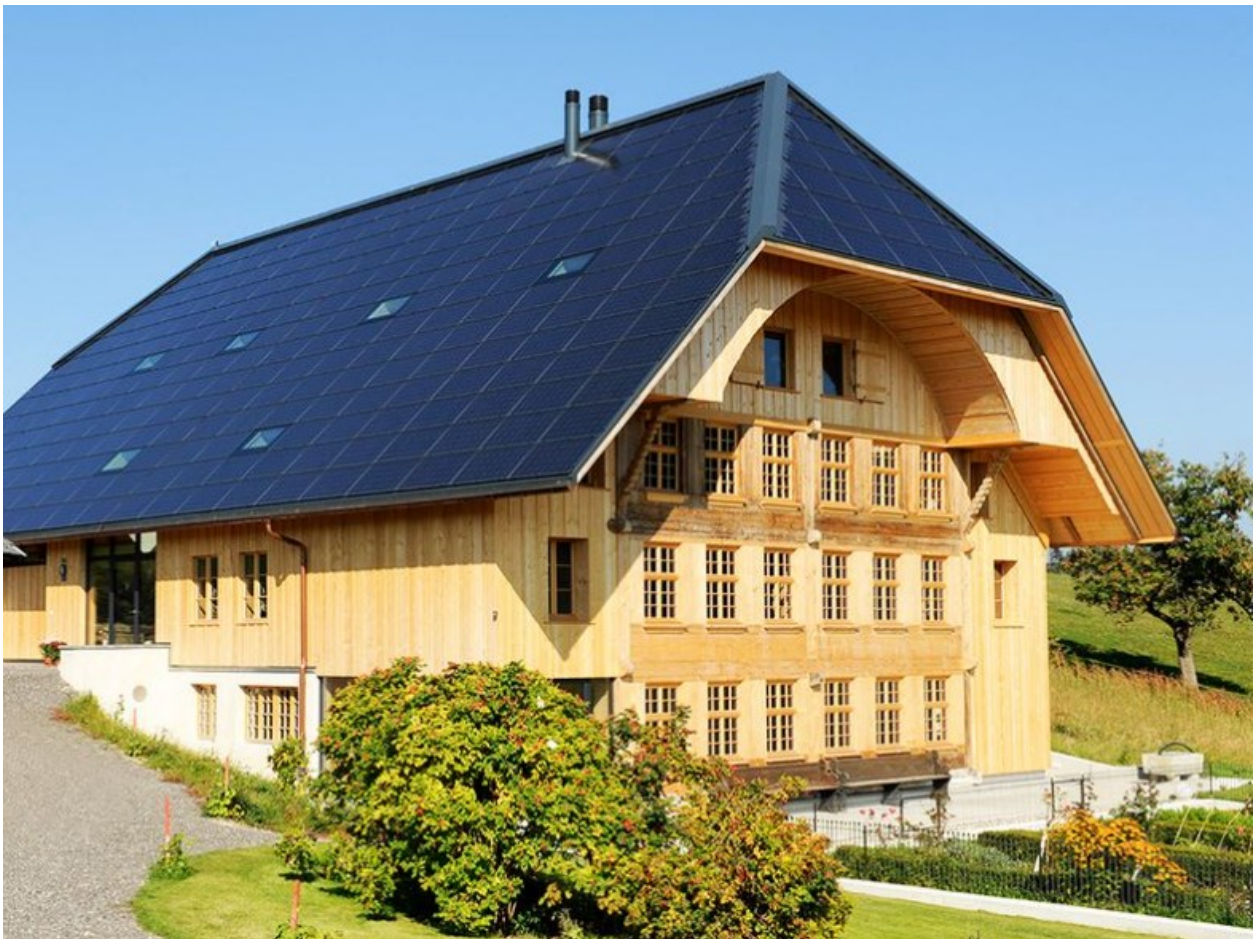
© clevergie AG, casa storica "PlusEnergy" nell'Emmental con impianto fotovoltaico completamente integrato su tutte le falde.
