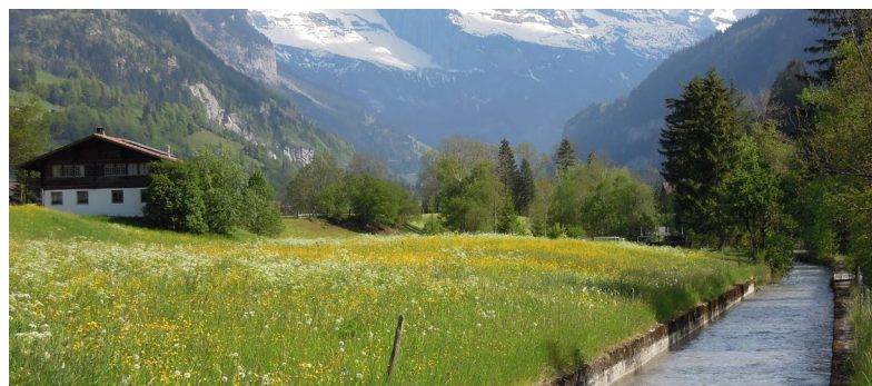
Canale di derivazione della piccola centrale idroelettrica presso la fabbrica di ardesia a Frutigen
