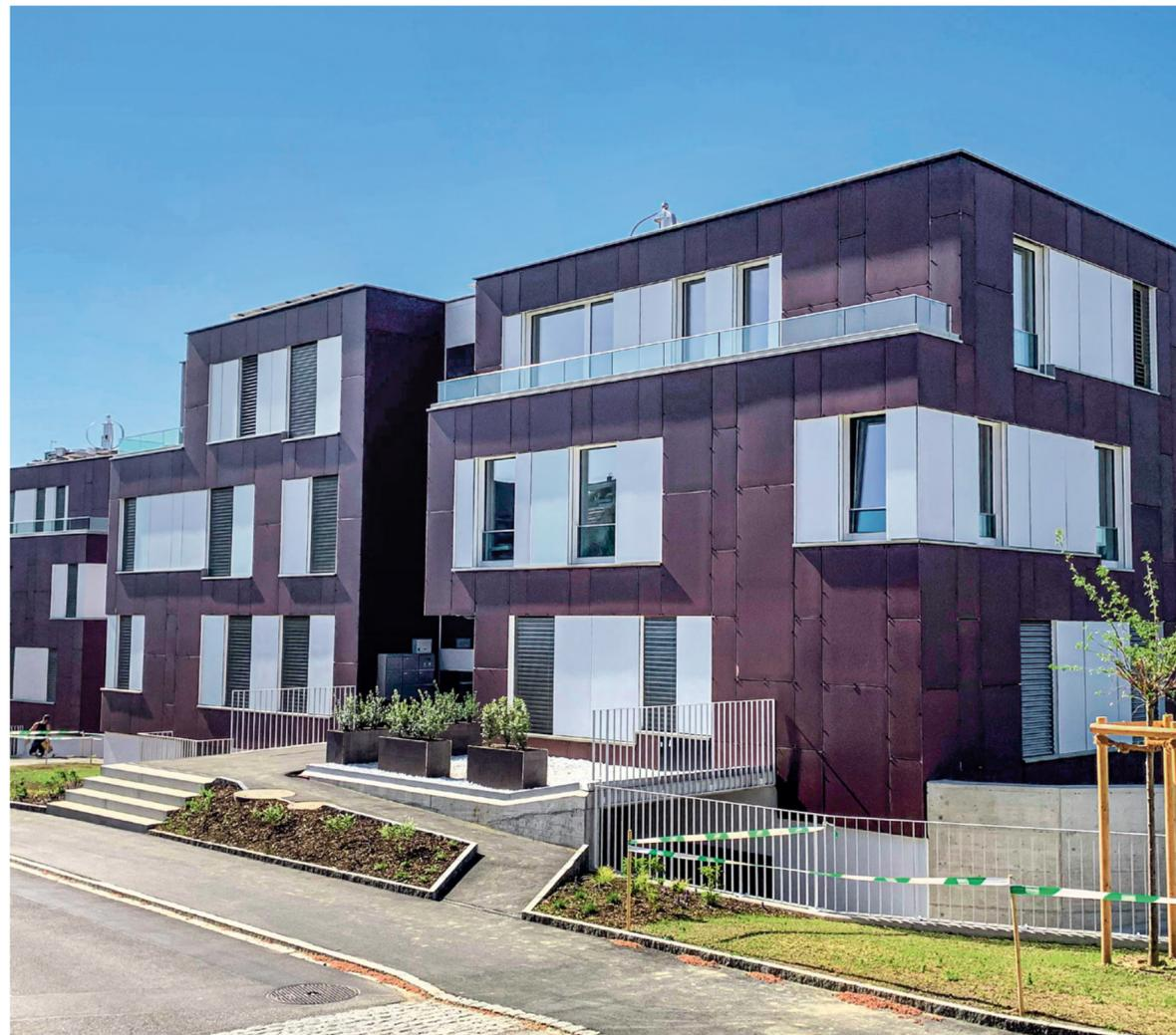
**Bianco:** anche se i moduli fotovoltaici neri raggiungono la massima efficienza, anche i moduli bianchi forniscono un buon rendimento. In questo progetto pilota a Männedorf (ZH) è attiva l'intera facciata; i moduli bianchi con rivestimento Solaxess utilizzano onde luminose invisibili. Questo progetto sarà presentato anche nella Umwelt Arena Schweiz.
