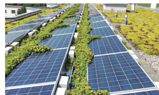
Possono apparire belli, ma compromettono la resa energetica degli impianti fotovoltaici: piante ombreggianti sui pannelli solari. (Foto: Contec)
