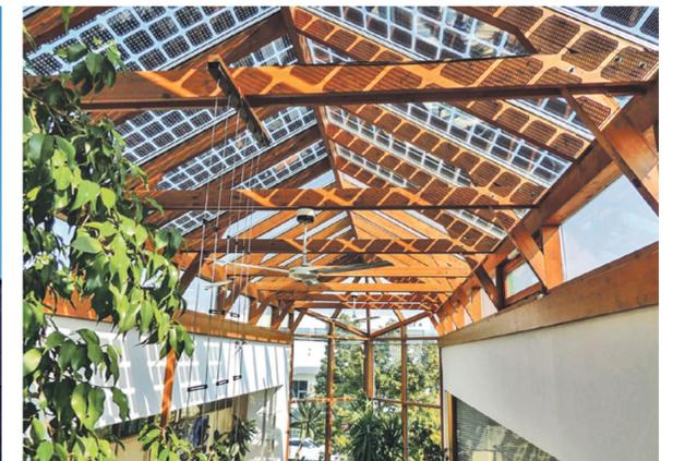
**Semi-trasparente:** oltre che per la produzione di elettricità, questi pannelli possono essere utilizzati, ad esempio, come copertura, per l'ombreggiamento o come schermi per la privacy.
