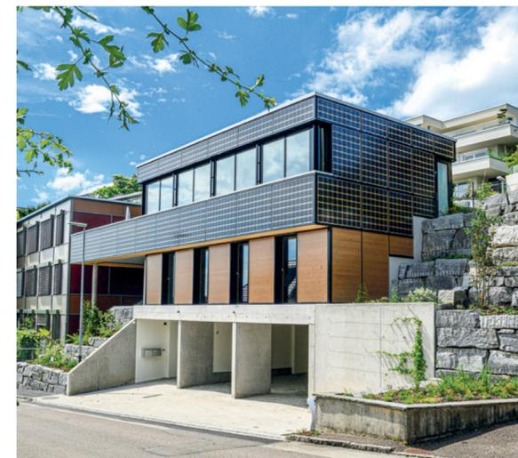
**Bifacciale:** l'impianto FV in facciata della casa bifamiliare a energia positiva a Wül (SG) sfrutta sia l'irraggiamento solare diretto sia la luce solare riflessa dalla facciata. L'aria riscaldata tra l'impianto FV e la facciata viene utilizzata per far funzionare una pompa di calore.
