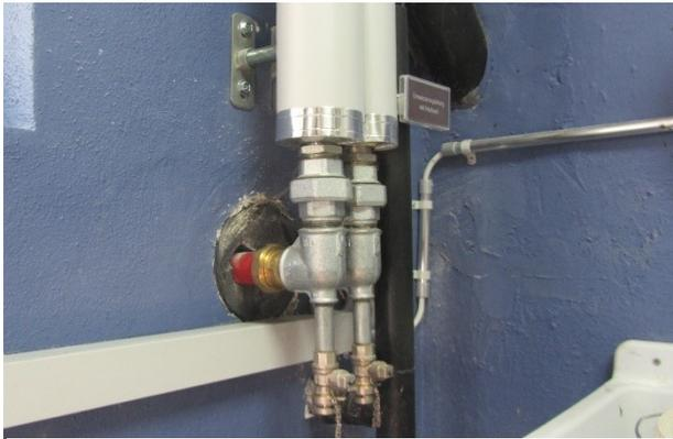
Photo 6 : Arrivée des conduites des conduites isolées et enterrées dans la cave
