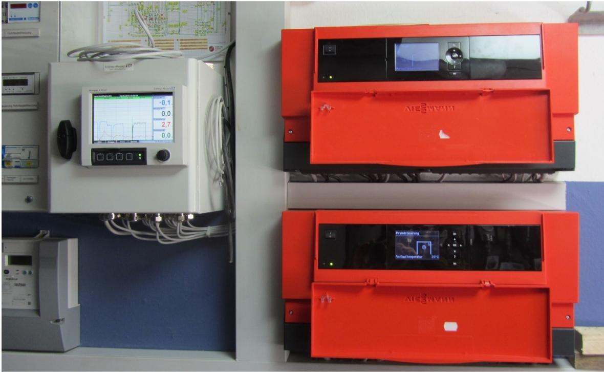
Photo 9 : Distributeur électrique principal, Logger et commande des pompes à chaleur (de droite à gauche)
