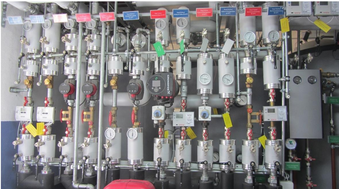
Photo 8 : Groupes de chauffage (premier plan) et accumulateur d'énergie (arrière-plan)
