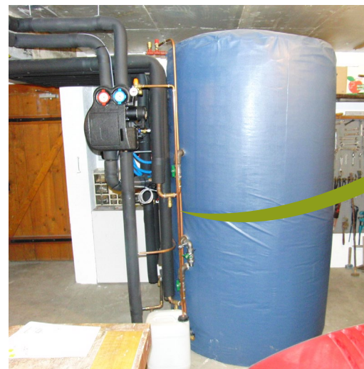
Conduite de sortie résistante à la température menant jusqu'au sol
