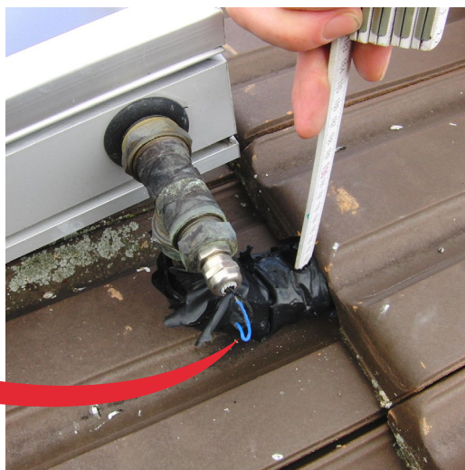
Câble de capteur non protégé
