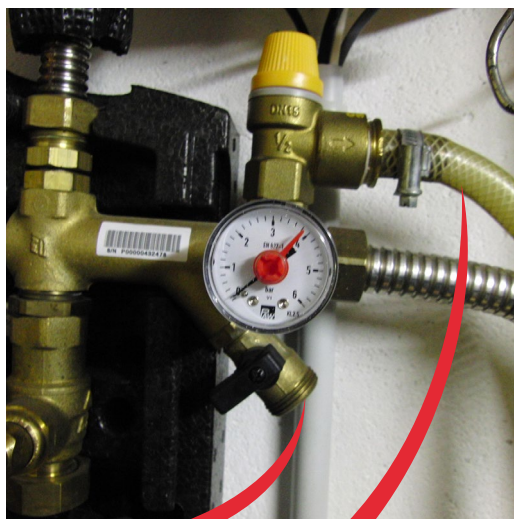
Tuyau d'arrosage non résistant à la température
