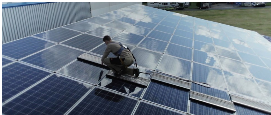
Illustration 8 : Utilisation d'un multiboard solaire, SMB Solar Multiboard GmbH
