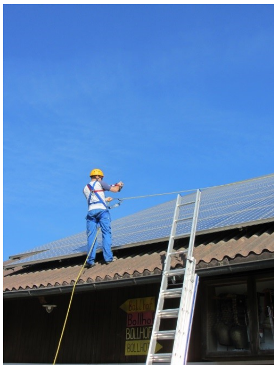
Illustration 9 : Protection par encordement, BE Netz AG
