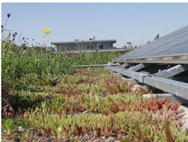
Illustration 12 : Zone de sedums devant les modules PV, Dr. Stephan Brenneisen, ZHAW Wädenswil
