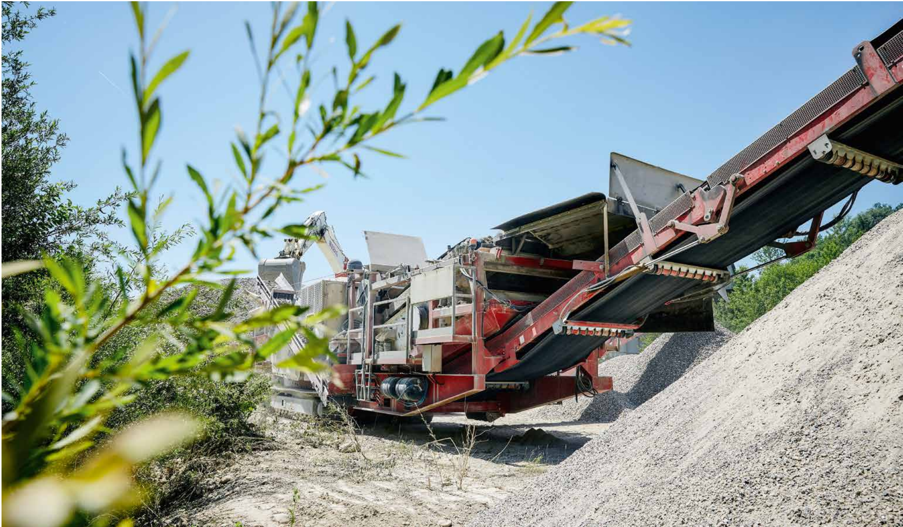
Gravière Aebisholz près d'Oensingen (SO) : un concasseur mobile réduit les morceaux de béton en granulats, le matériau de base du béton recyclé
