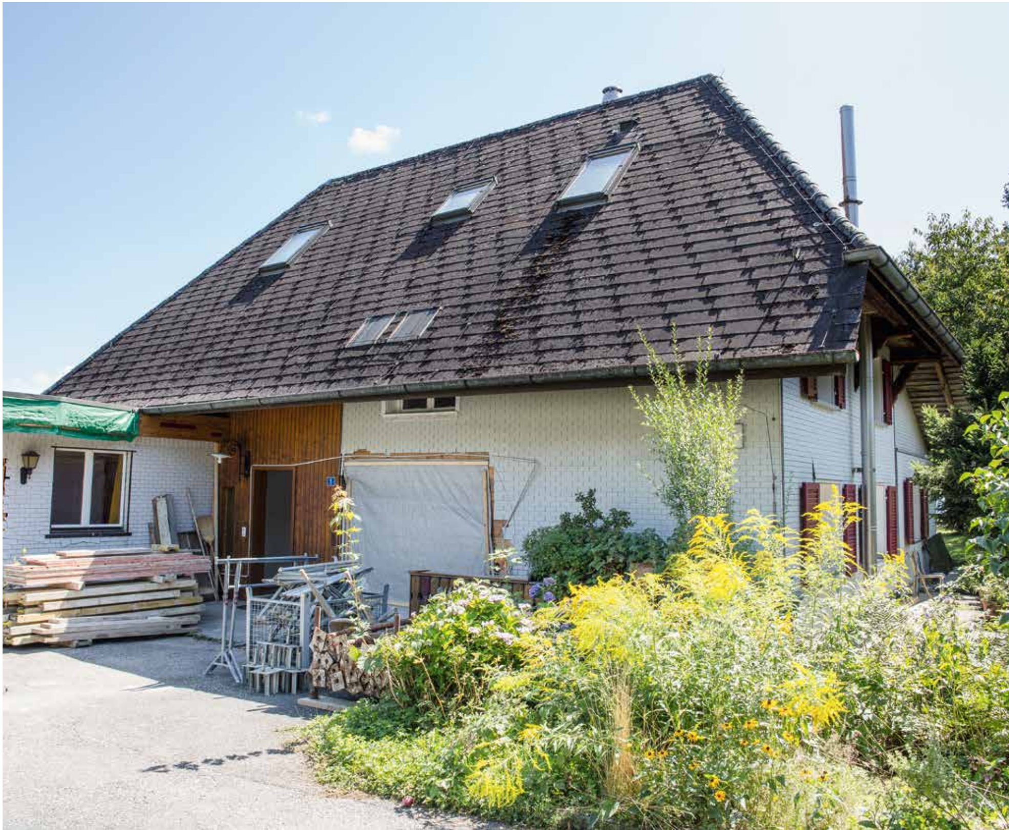
L'ancienne ferme située à Heimenhausen devrait être entièrement rénovée d'ici 2021 et dotée d'une nouvelle chaudière à bois, d'une pompe à chaleur en complément et d'une installation photovoltaïque
