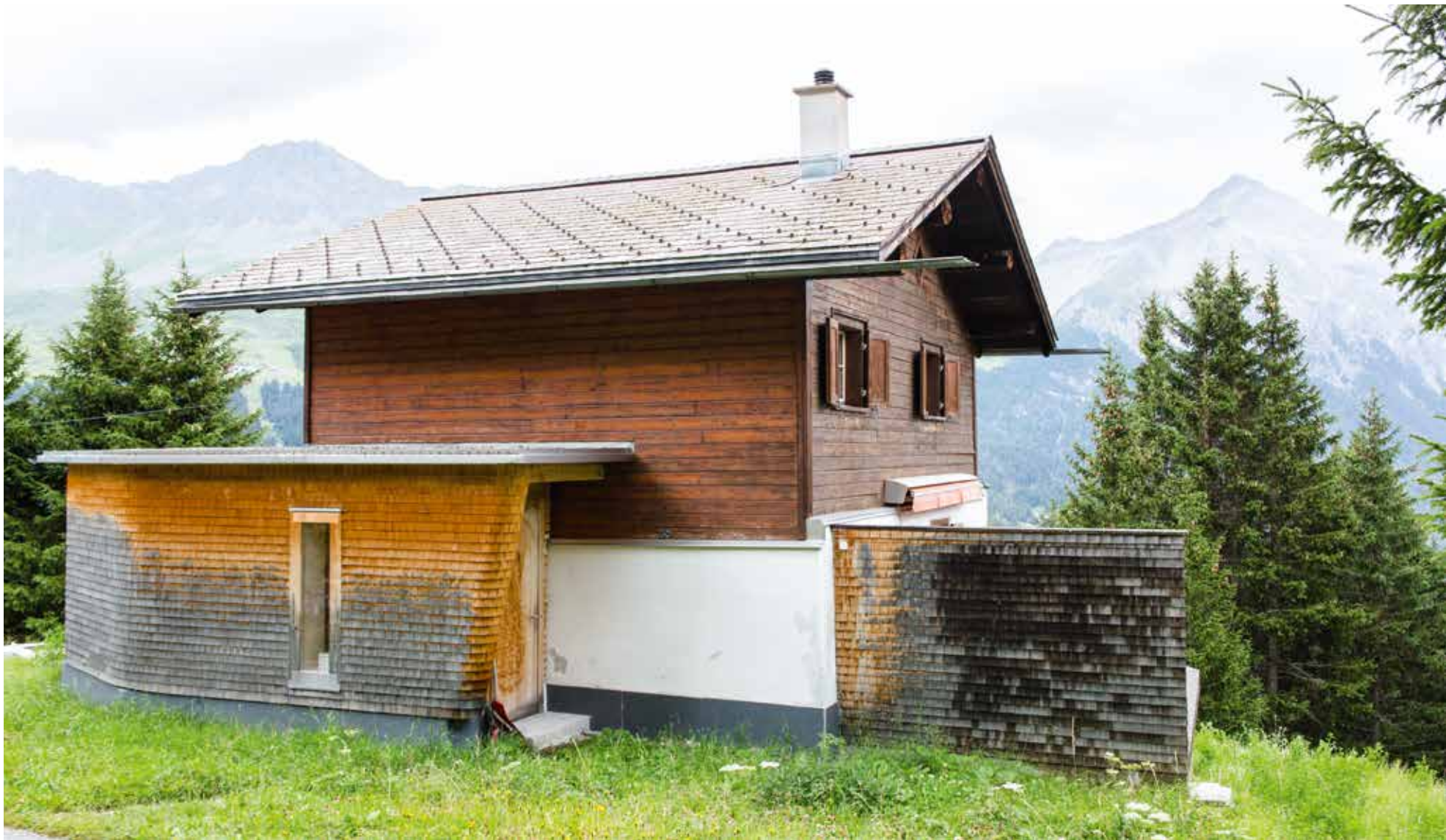
Une maison de vacances au-dessus de Lenzerheide : son propriétaire règle le chauffage via une application avant son arrivée.
