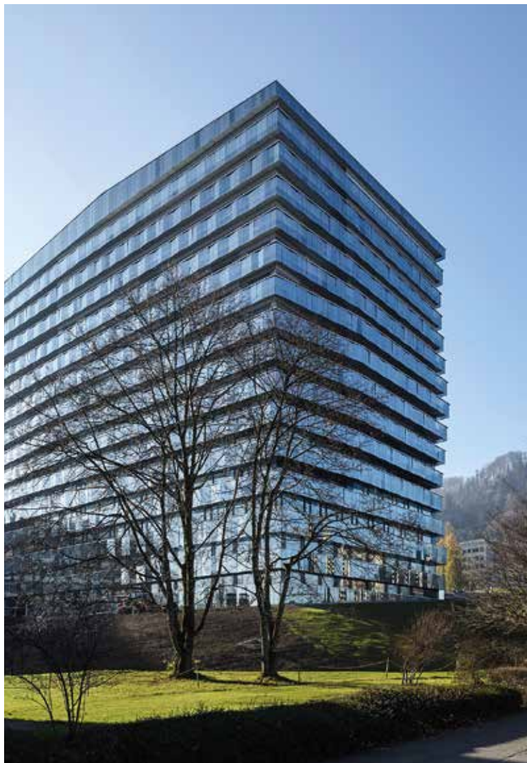
Hôpital municipal Triemli à Zurich : 97 pour cent du béton utilisé pour la construction du nouveau bâtiment provient de béton recyclé
