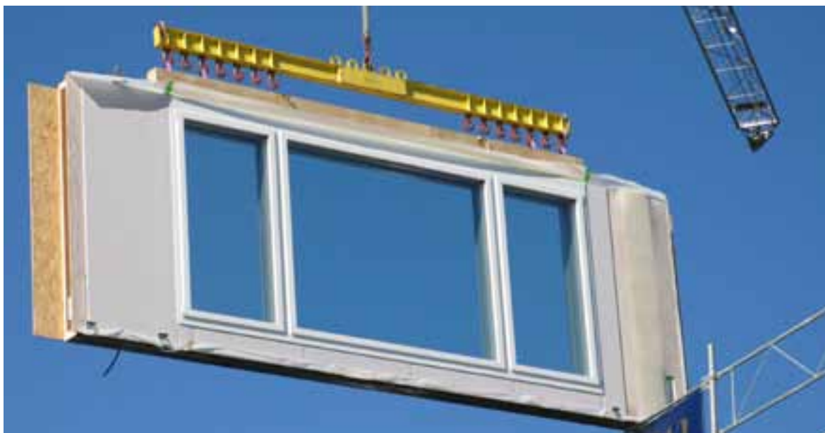
Rénovation d'un bâtiment locatif au moyen d'éléments préfabriqués. Le projet « Prefab Retrofit » de l'Agence internationale de l'énergie (AIE) développe, sous une direction suisse, des solutions novatrices permettant d'améliorer la performance de la rénovation des bâtiments locatifs. Les bâtiments sont mesurés en trois dimensions au moyen de scannage laser et de photographies aériennes. Les mesures relevées sont utilisées pour la préfabrication précise, en usine, des nouveaux éléments d'enveloppe. Les processus de construction sont ainsi fortement raccourcis. (Empa)
