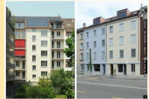
Bâtiment à énergie positive réalisé dans le quartier à haute densité d'habitation de Matthäus à Bâle (Feldbergstrasse 4-6, bâtiment de 1896, inscrit au patrimoine, combinaison d'une sur isolation thermique, d'implantation de capteurs solaires thermiques et photovoltaïques et de mise en place de réservoirs saisonniers de chaleur dans l'immeuble) (Prix Solaire Suisse 2009).
