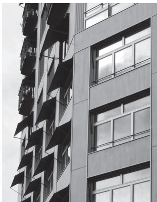
Sans joint - malgré des joints: Sur le bâtiment Hohes Haus West des architectes Loeliger Strub, des profilés en aluminium encadrent les panneaux en béton fibreux.
