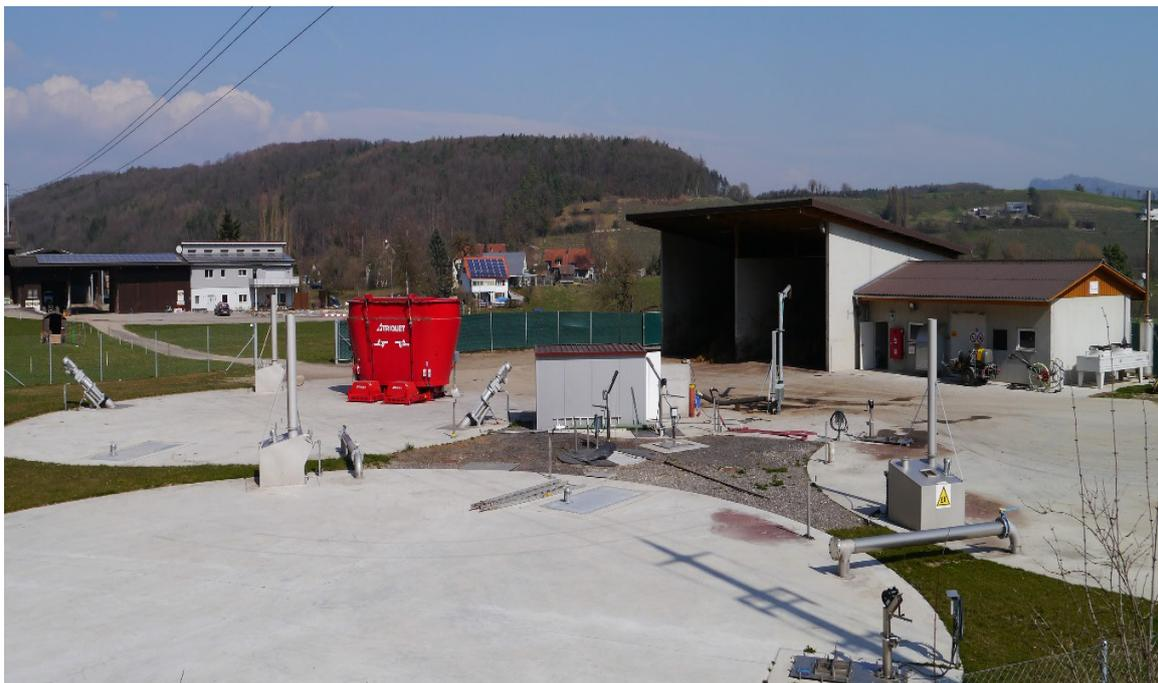
Figure 9: Vue sur l'installation de biogaz avec les cuves de fermentation souterraines
