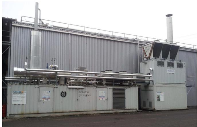
Figure 18 (à gauche): ORC de GE Energy (Source: GE Energy)
