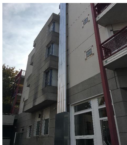
Photo 2 : Descente des conduites en façade
