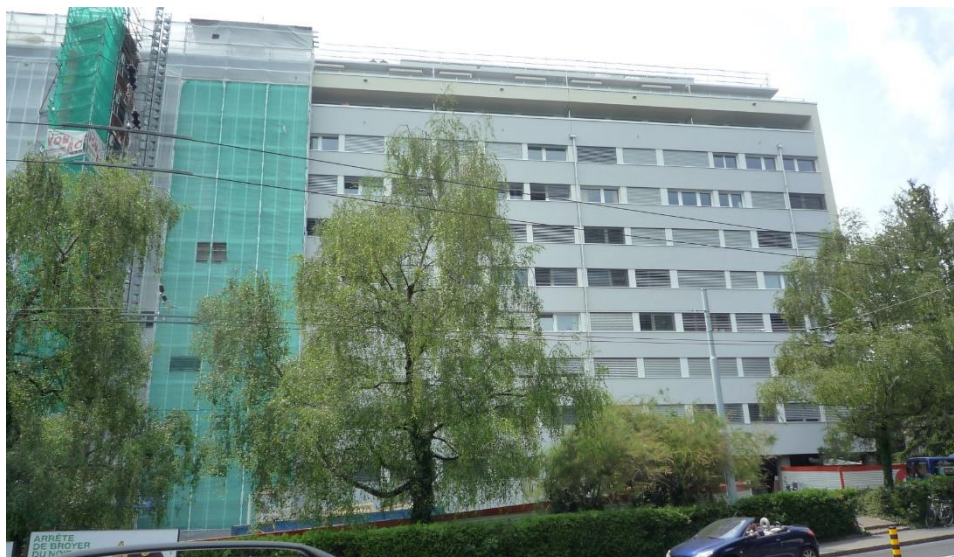
Photo 9 : immeuble résidentiel du projet lors de la phase de travaux
