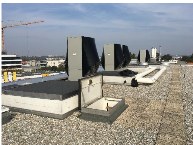
Photo 1 : Installation des PAC en toiture
