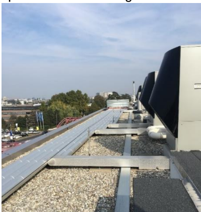
Photo 3 : Conduites hydrauliques sur la toiture plate du bâtiment
