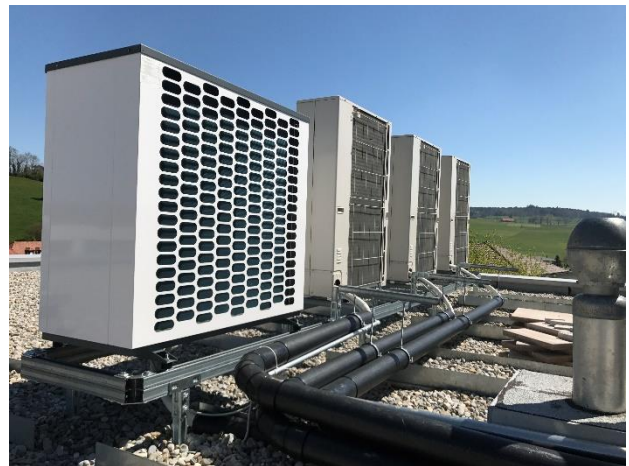
Photos 7 et 8 : Disposition des unités splits en toiture de l'immeuble
