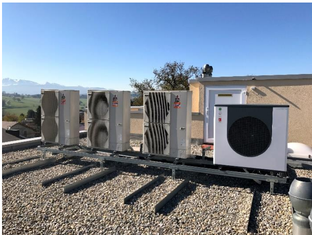
Photos 7 et 8 : Disposition des unités splits en toiture de l'immeuble
