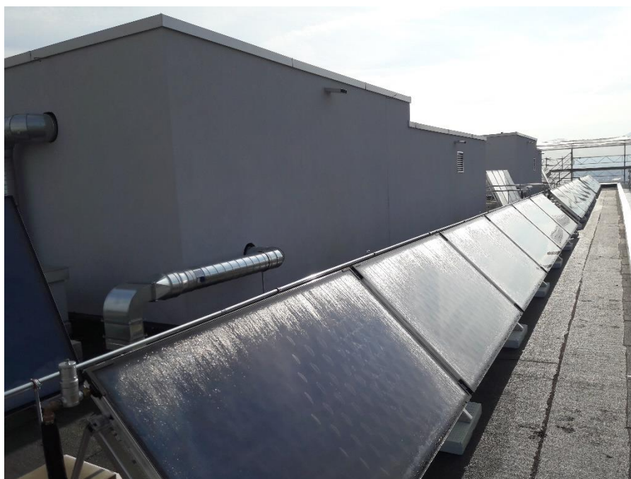
Photo 11 : Panneaux solaires sur la toiture, devant les locaux techniques pour les monoblocs de ventilation
