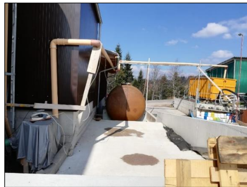
Figure 3: État des travaux: les fondations des deux nouveaux réservoirs d'hydrolyse sont prêts (illustration: wigako) Fermentation en deux étapes: 1 re étape de l'hydrolyse anaérobie de substrats liquides
