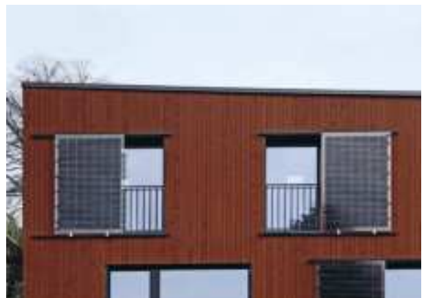
VOLETS COULISSANTS SOLAIRES POUR IMMEUBLE D'HABITATION, WIESENSTRASSE, KÜSNACHT Architecture : Vera Gloor, Zürich Partenaire spécialisé, photovoltaïque : Leutenegger Energie Control, Küssnacht
