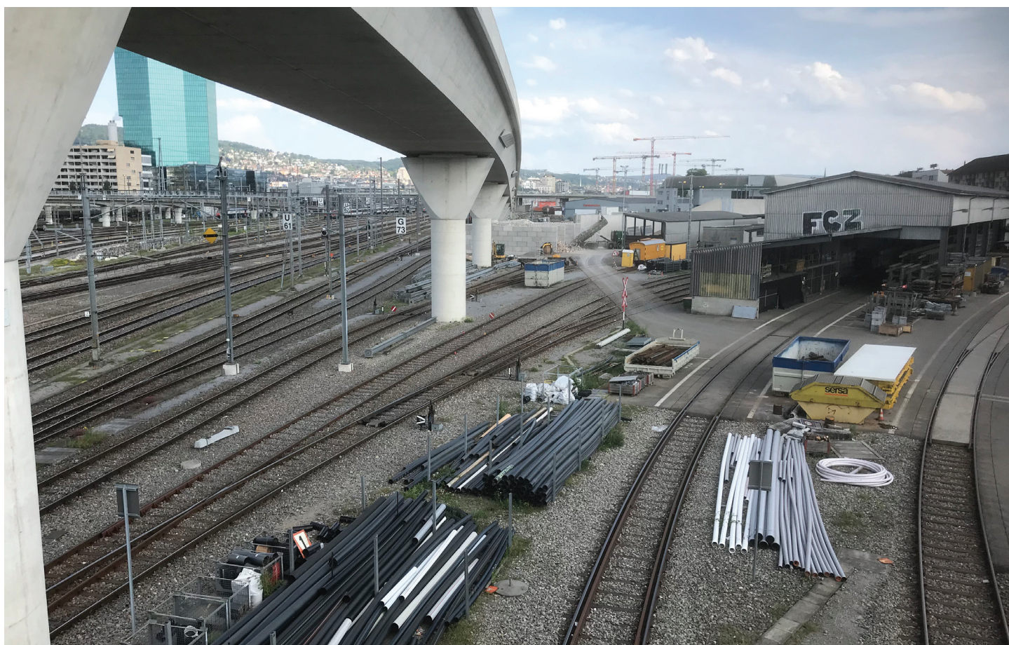
Le site Hardfeld de Zurich: une entreprise d'enlèvement des déchets y stocke les déchets de construction et les déchets encombrants afin de trier les composants pour le recyclage. Photo: B. Vogel
