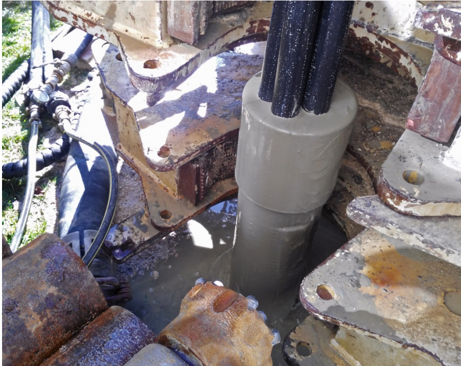
Fig. 5 Remplissage qui sort de la tête de puits
