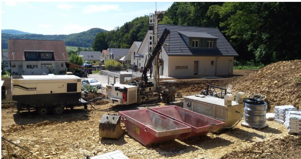
Figure 2 Forage géothermique avec machine de forage, compresseur, benne de récupération des boues, ciment et sonde
