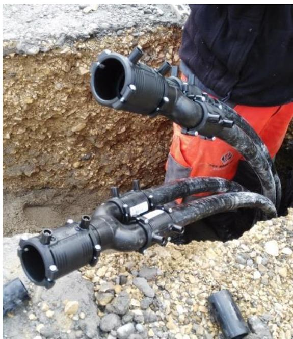
Figure 13 Les deux tuyaux d'arrivée et de retour des sondes sont connectés à l'aide d'un Y, et raccordés au collecteur à l'aide de conduites PE50
