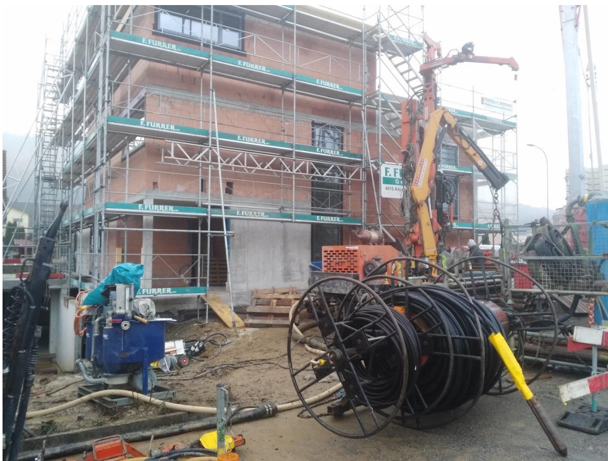
Figure 6 Tuyau de la sonde avec tuyau pour l'injection du ciment de remplissage sur le dérouleur. Le pied de sonde est lesté
