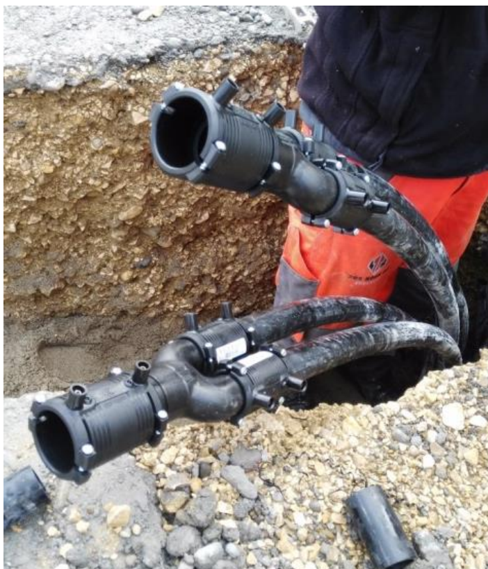
Figure 11 Les deux tuyaux d'arrivée et de retour des sondes sont connectés à l'aide d'un Y, et raccordés au collecteur à l'aide de conduites PE50
