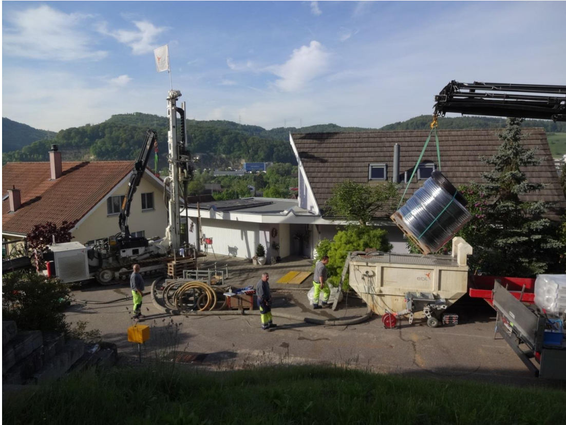
Figure 4 Dispositif de forage avec machine de forage, benne de récupération des boues, sonde, pompe mélangeuse et camion
