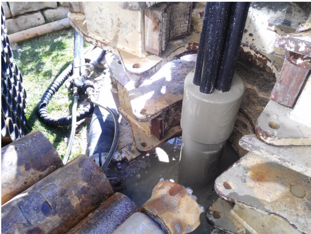
Figure 8 Cimentation complète du forage, Le ciment est visible depuis la surface
