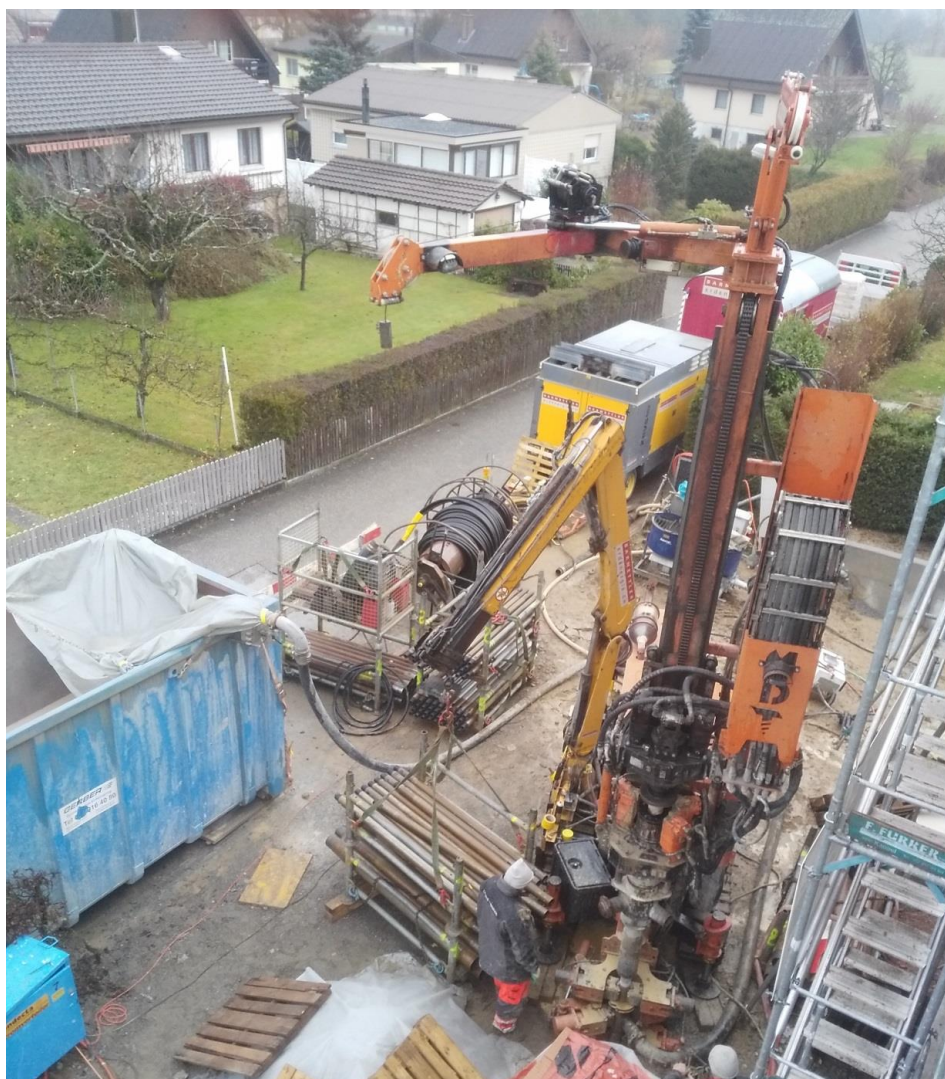
Figure 5 Machine de forage, avec équipement en bord de route (benne de récupération des boues, tuyau, compresseur, conteneur de chantier, camionnette)
