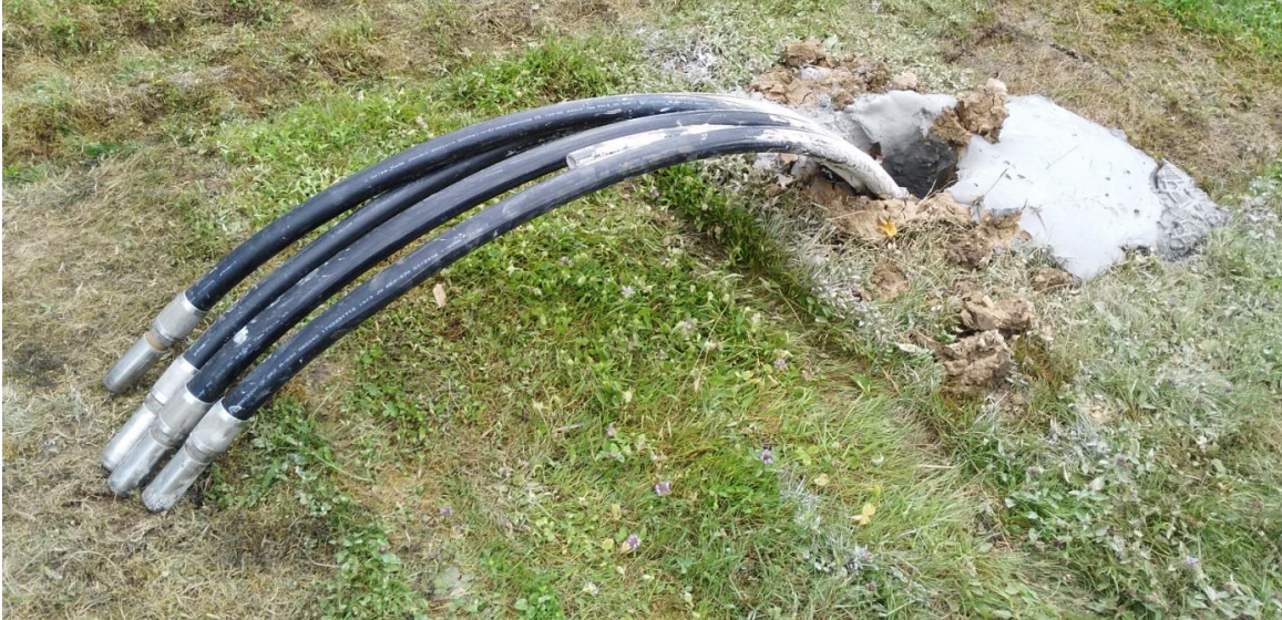
Figure 9 Les sondes restent étanches à la pression après le remplissage. Le ciment de remplissage s'est quelque peu affaissé dans le trou, et ce dernier doit être complété
