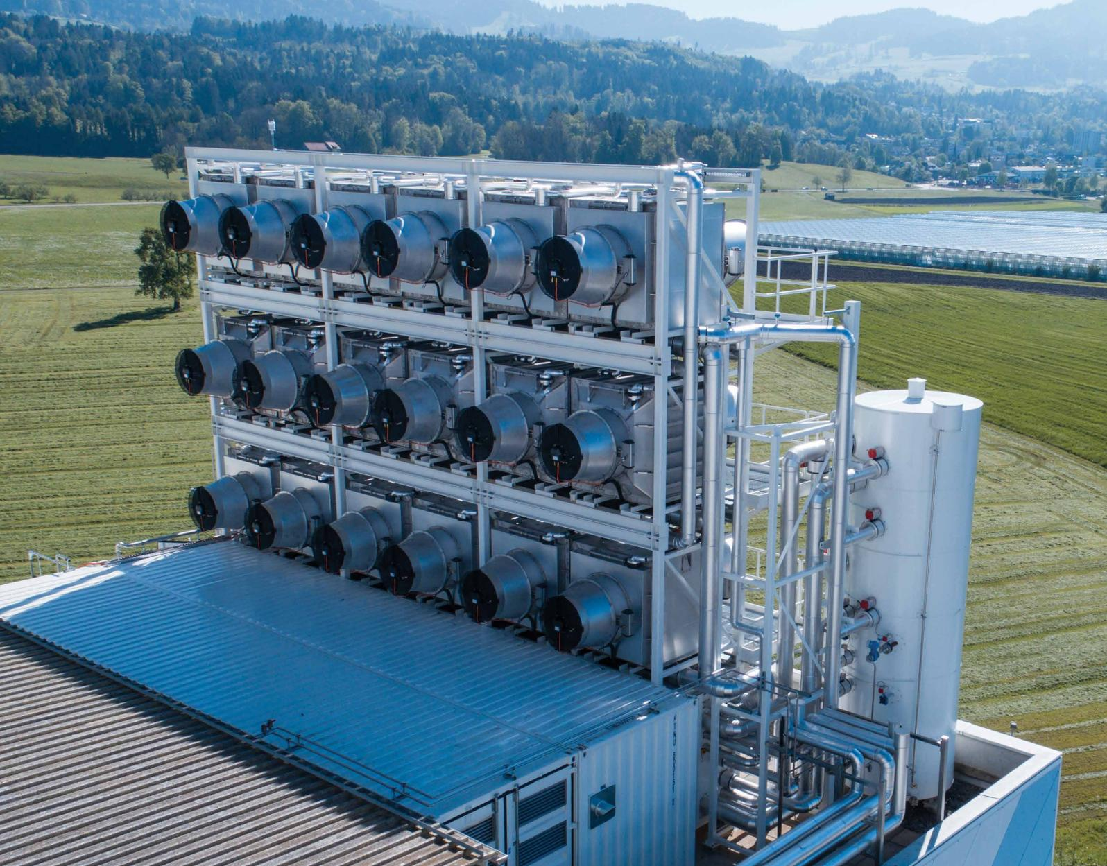
Installation de la firme suisse « Climeworks AG » à Hinwil pour la récupération du dioxyde de carbone de l'air ambiant (source : Climeworks AG).
