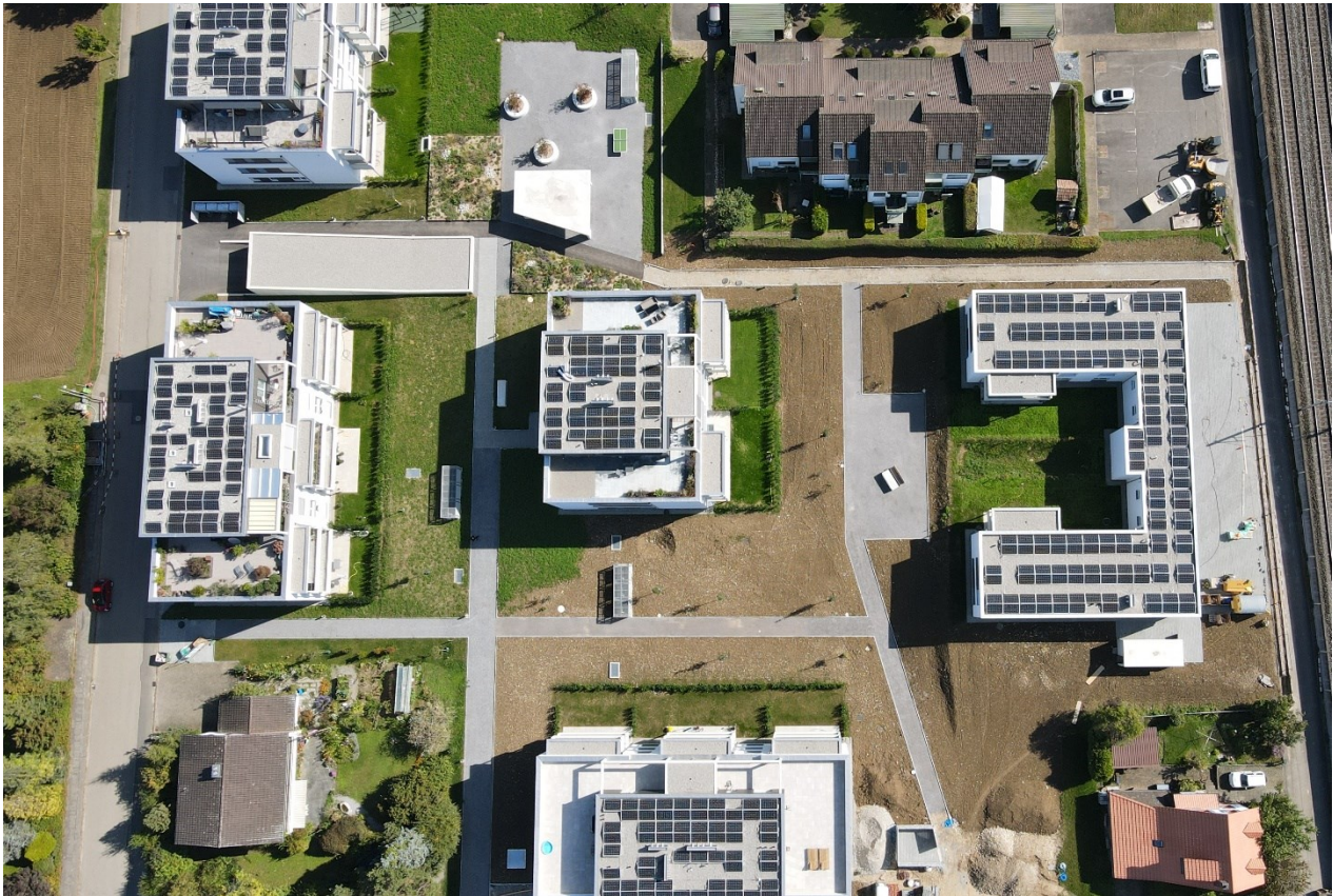
RCP de 5 immeubles locatifs à Ittingen, Bâle Campagne © Solarspar, Sissach
