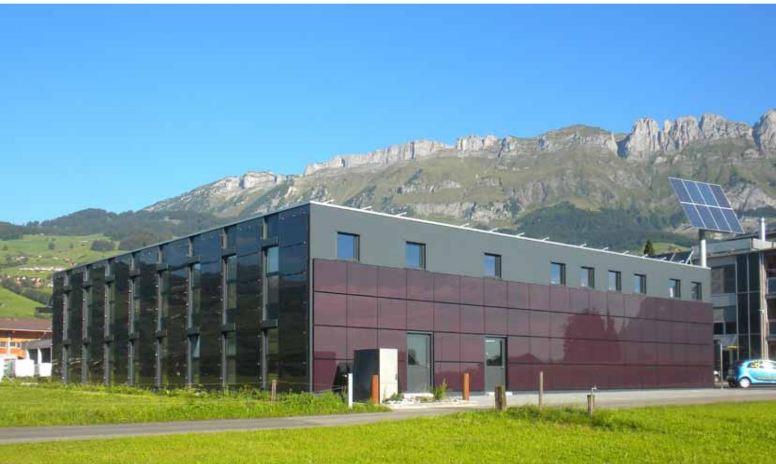
**Titelbild:****Vom Gebäude zum Kraftwerk: Photovoltaik auf Dach und Fassaden**
