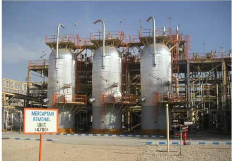
Figur 3: «Schwefelentfernung aus Erdgas mittels Zeolith»-Weltklasse-Anlage zur Entfernung von Merkaptanen aus Erdgas: Pro Bett (Turm) sind über 40 Tonnen Zeolith enthalten. Die ganze Anlage besteht aus zwei parallelen Strängen mit je 6 Betten.
