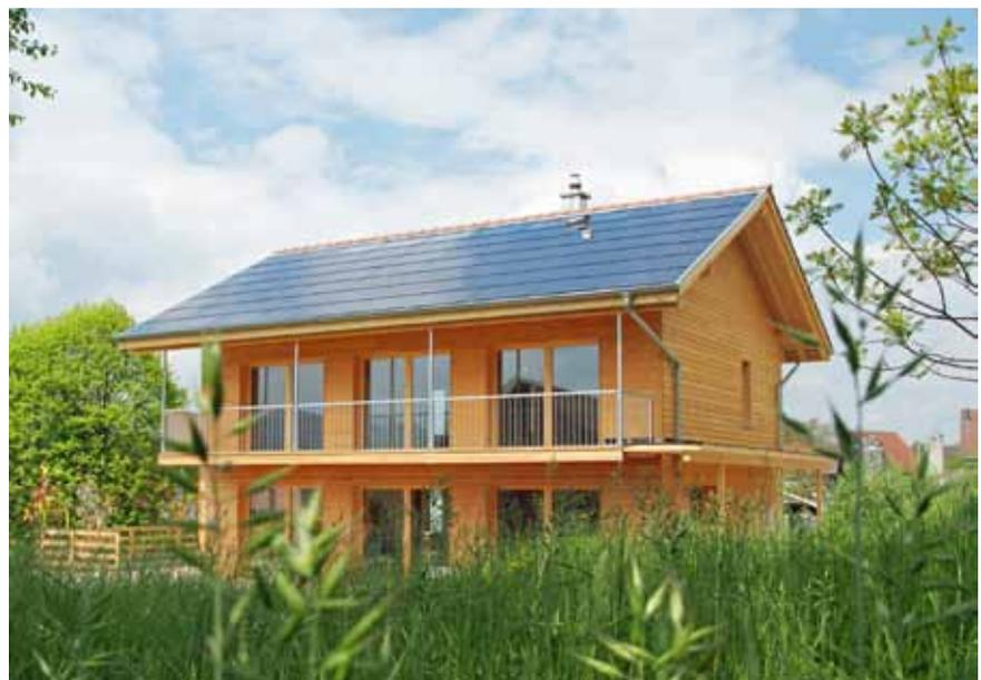
Figur 6: Gebäudeintegrierte Photovoltaik-Pilotanlage ( $9,6\text{ kW}_p$ ) mit dem neuen Smart-Tile System (Bildquelle: 3S Swiss Solar Systems).
