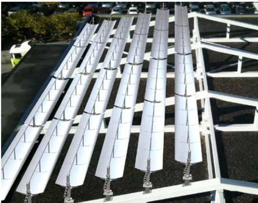
Figure 6 : Exemple de possible configuration de l'installation des collecteurs paraboliques linéaires chez Cremo.
