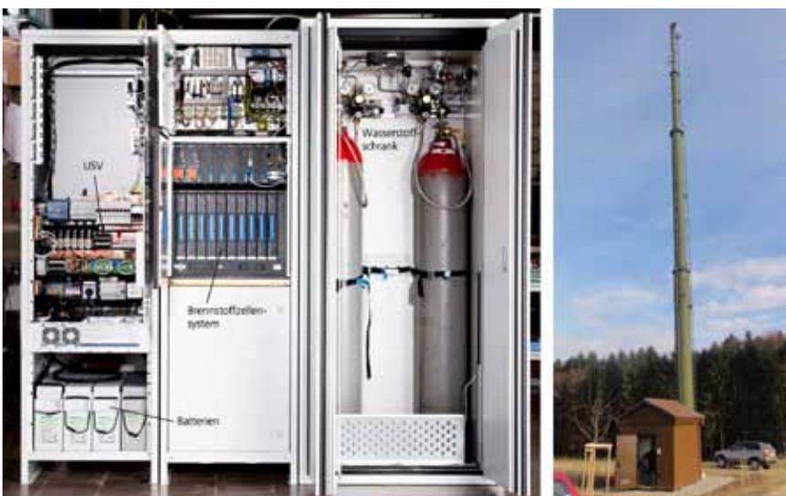
Figur 6: (Links) Integration eines kommerziellen Brennstoffzellensystems (T2000 von ReLion) in ein System zur unterbrechungsfreien Stromversorgung (UPS, Benning) (HTA Luzern). Die Leistung der Anlage liegt bei 2 bis 4 kW mit einer Autonomiezeit von bis zu 48 Stunden. (Rechts) Einsatz des UPS-Systems in einer Antennenanlage des Kantonspolizei Bern für das Sicherheitsfunknetz POLYCOM..
