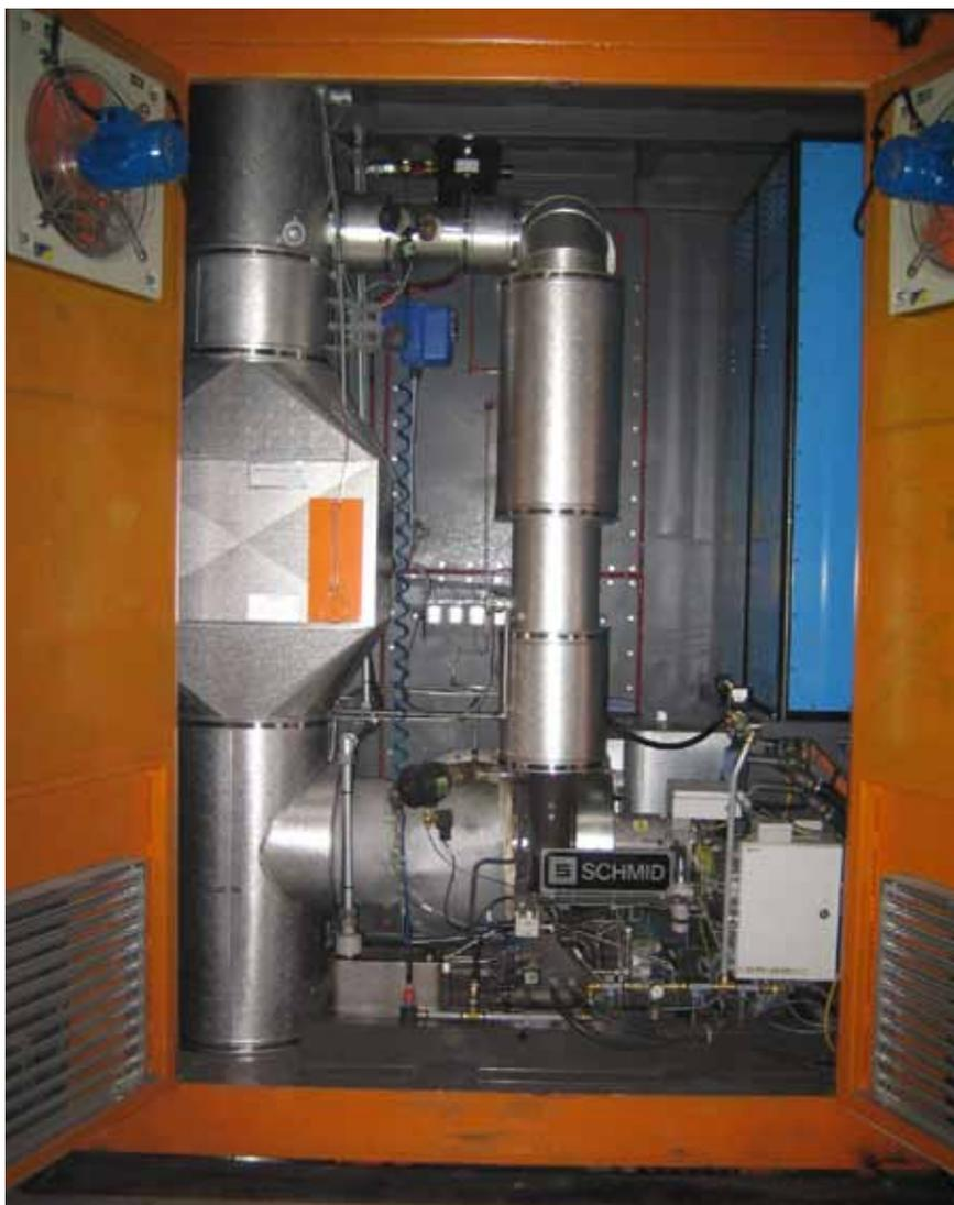
Figur 6: Maschinenraum der mit Hackschnitzeln befeuerten Heissluftturbine (Quelle: Schmid AG).
