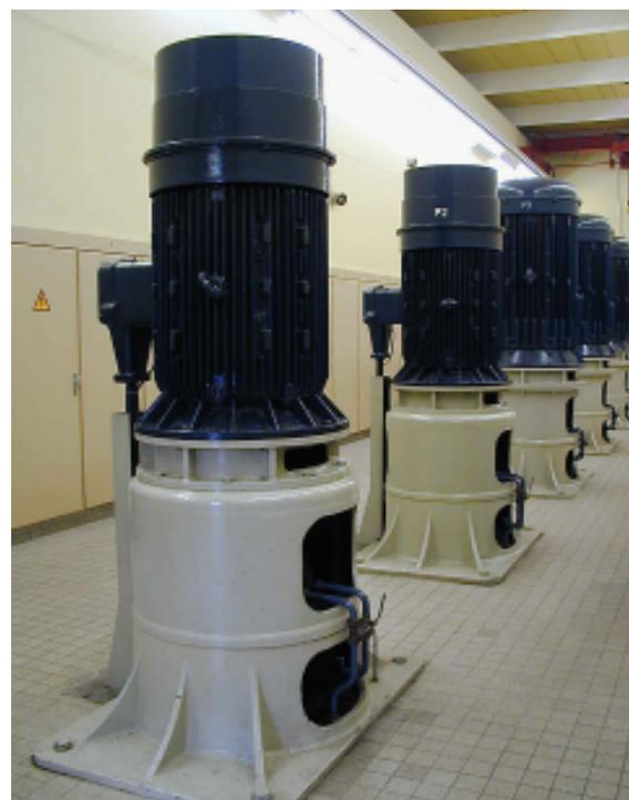
**Figur 5:** Netzwasserpumpen bei Novartis
