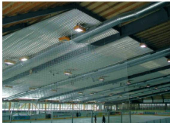
Figur 2: Neuinstallierte Aluminium-Deckenuntersicht
