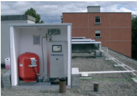
**Figur 10:** Solarinnovation: über das in einem wettergeschützten Gehäuse untergebrachte Solar-Kompaktmodul heizen Solarkollektoren direkt das zirkulierende Warmwasser von Mehrfamilienhäusern. Dazu wird die Zirkulationsleitung vom obersten Geschoss bis aufs Dach verlängert. (Foto: Oekozentrum Langenbruck)
