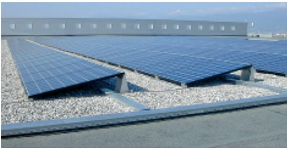
**Figur 25:** 70 kWp Flachdachanlage Palexpo
