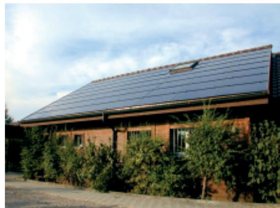
**Figur 22:** 15 kWp Dachintegration Weiermatt (Bildquelle NET)
