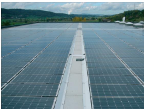
**Figur 14:** 62 kWp Anlage mit PowerGuard Modulen (Bildquelle Zagsolar)
