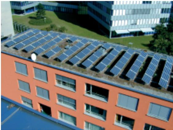
**Figur 17:** Gründachanlage Solgreen Kraftwerk 1 Zürich (Bildquelle NET)
