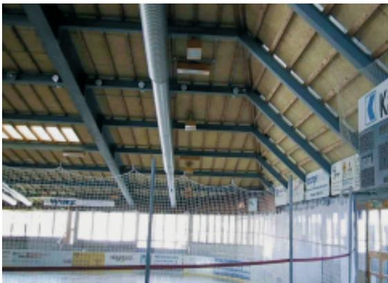
Figur 1: Zustand vor Sanierung mit Faserholzdecke
