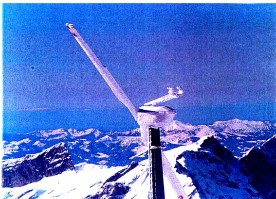
35'000 kWh. Dies liegt an der häufiger als angenommen auftretenden Vereisung der Anlage, was durch die markanten Windgeschwindigkeitsunterschiede zwischen beheiztem und unbeheiztem Anemometer belegt werden kann.
