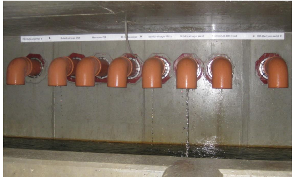
Sortie des conduites de drainage
