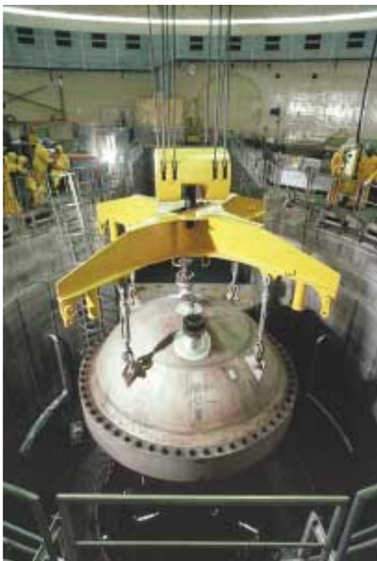
*Le couvercle de la cuve du réacteur est soulevé lentement après desserrage et retrait des 60 goujons filetés de fixation. L'accès aux assemblages combustibles et aux structures internes de la cuve du réacteur supportant le cœur est alors libéré.*
