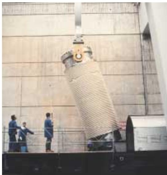
Conteneur de transport pour assemblages combustibles irradiés. Le conteneur est délicatement déposé sur le wagon de chemins de fer et mis en position horizontale
