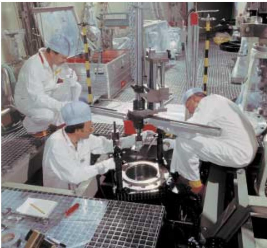
Travaux sur une vanne d'alimentation du système de refroidissement de l'eau de la piscine de stockage des assemblages combustibles
