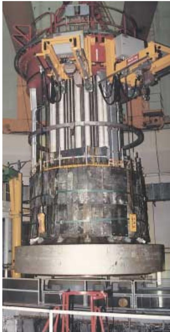
*Opération de levage du couvercle de la cuve du réacteur, avec les entraînements des grappes de commande. Un écran de blindage temporaire fait de nattes de plomb protège le personnel contre les rayonnements ionisants.*
