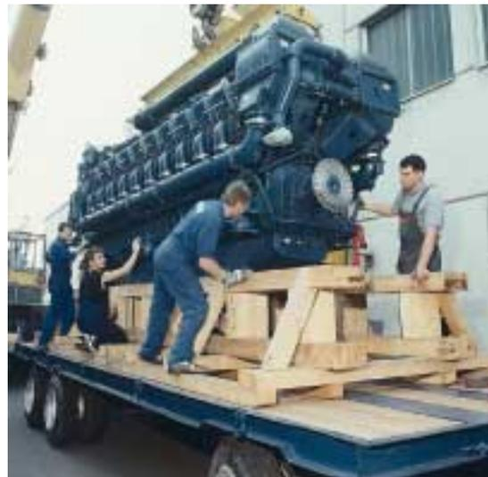
*Échange du moteur diesel d'un groupe électrogène de l'alimentation électrique de secours. Déchargement du moteur de rechange à son arrivée par camion sur le site de la centrale nucléaire. Source: centrale nucléaire de Leibstadt*
