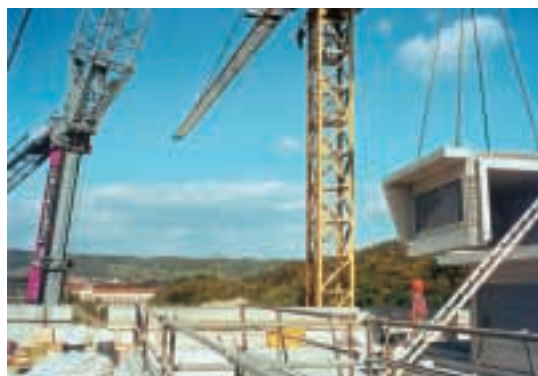
Travaux de construction du nouvel entrepôt pour déchets hautement radioactifs (ZWIBEZ) sur le site de la centrale nucléaire de Beznau Source: centrale nucléaire de Beznau
