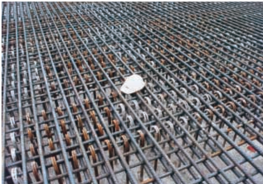
Fers d'armature avant le bétonnage de la dalle de toiture renforcée d'un bâtiment de l'Entrepôt central pour déchets radioactifs (Würenlingen)
