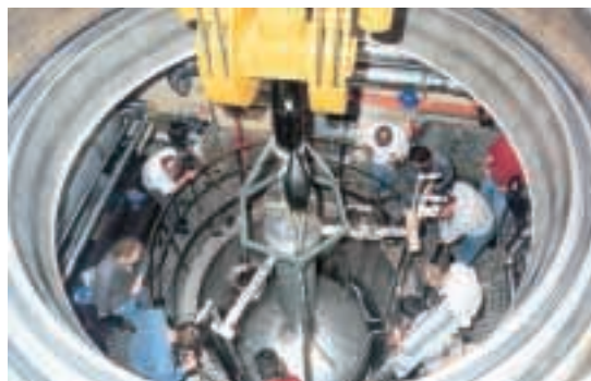
Mise en place de la cuve du modérateur à l'intérieur du blindage (écran biologique) de la source de neutrons par spallation (SINQ) du PSI
