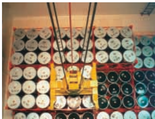
Opérations de stockage de fûts de déchets radioactifs conditionnés dans l'Entrepôt fédéral de déchets radioactifs (BZL) Source: Paul Scherrer Institut
