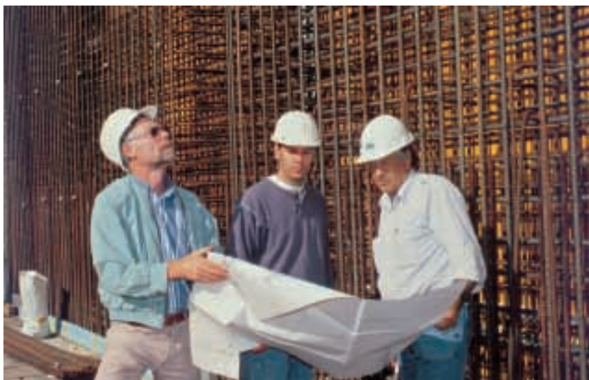
Consultation des plans devant les fers d'armature avant le bétonnage d'un mur renforcé d'un bâtiment de l'Entrepôt central pour déchets radioactifs (Würenlingen)
