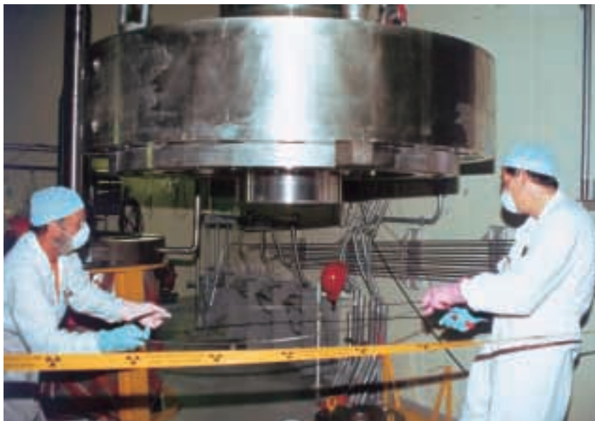
Mise en place d'un joint d'étanchéité annulaire dans une pompe principale de circulation du caloporteur du réacteur
