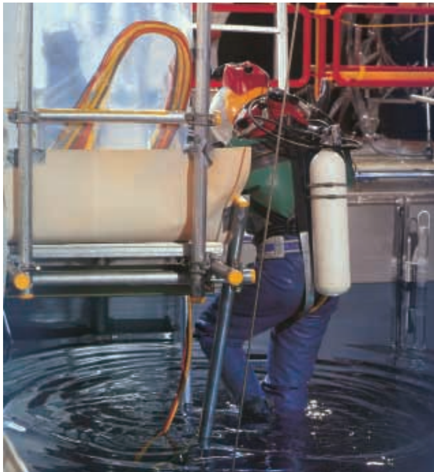
Travaux sous-marins dans le bassin d'entreposage des assemblages combustibles
