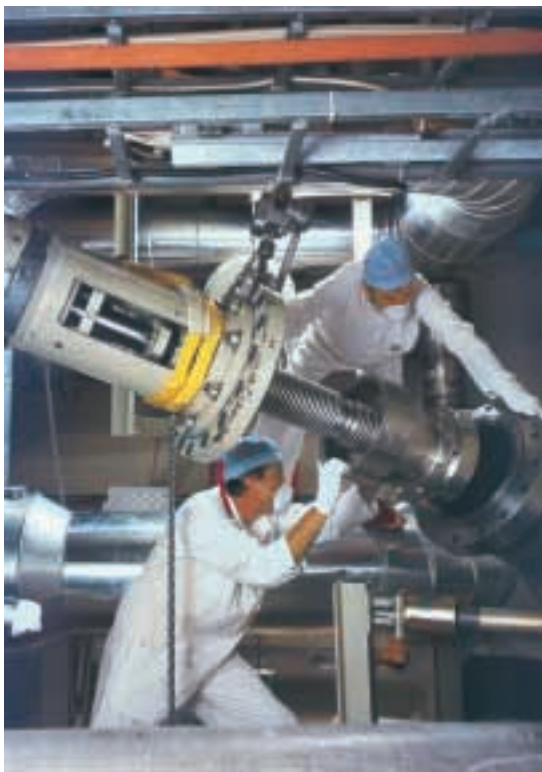
Remontage de la partie supérieure, révisée, d'une soupape faisant partie du dispositif de fermeture d'un réservoir de noyau Source: centrale nucléaire de Gösgen
