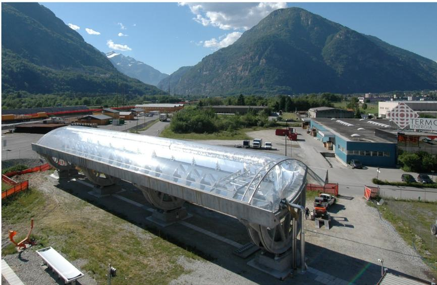
Figure 2 : Troisième prototype de concentrateur Airlight construit à Biasca TI.
