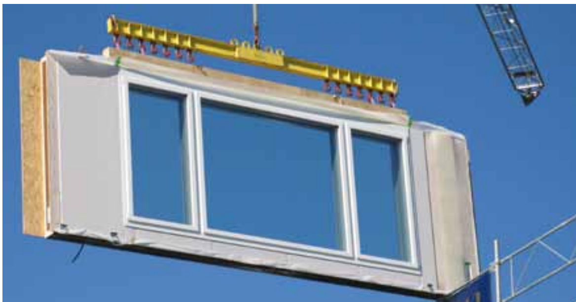
Rénovation d'un bâtiment locatif au moyen d'éléments préfabriqués. Le projet «Prefabricated Systems for Low Energy Renovation of Residential Buildings (ECBCS Annex 50)» de l'Agence internationale de l'énergie (AIE) développe, sous une direction suisse, des solutions novatrices permettant d'améliorer la performance de la rénovation des bâtiments locatifs. Les bâtiments sont mesurés en trois dimensions au moyen de scannage laser et de photographies aériennes. Les mesures relevées sont utilisées pour la préfabrication précise, en usine, des nouveaux éléments d'enveloppe. Les processus de construction sont ainsi fortement raccourcis. (Empa)
