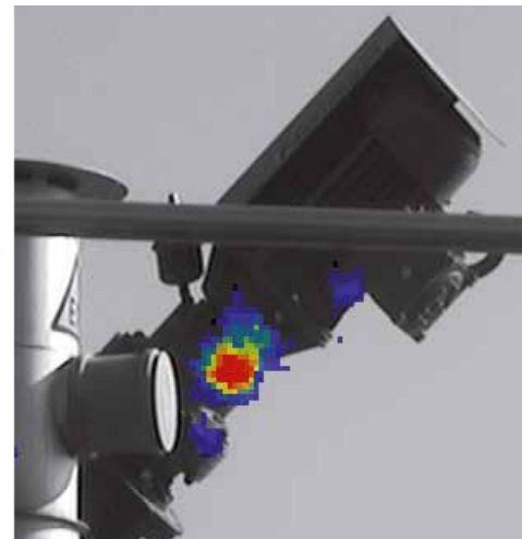
Fuites de gaz dans l'agitateur d'une installation au biogaz. Les surfaces colorées en rouge montrent les fortes concentrations de méthane et celles en bleu les faibles concentrations. A gauche : avant le graissage, à droite : après le graissage.
