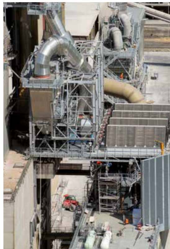
Les rejets thermiques d'une cimenterie peuvent être utilisés pour produire de l'électricité grâce à une installation d'Organic Rankine Cycle (ORC).
