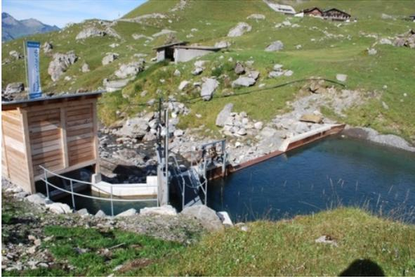
III. 14 : Petite centrale hydraulique réhabilitée sur l'Engstligenalp; prise d'eau à 1927 mètres d'altitude [31]; puissance installée de 600 kW (précédemment 60 kW)
