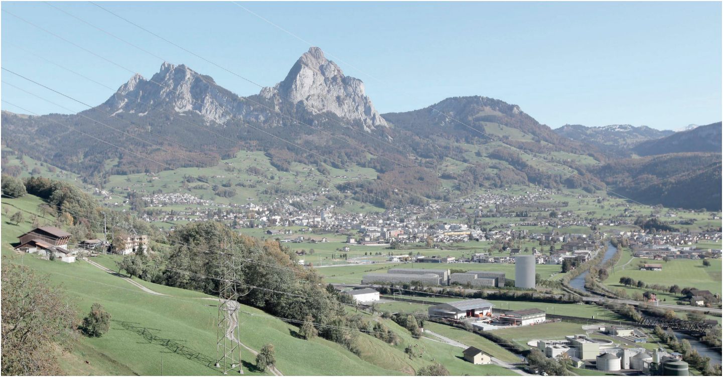
L'accumulateur de chaleur prévu de la société Argo Energie Schwyz AG a une hauteur de 50 mètres, un diamètre de 30 mètres et peut stocker jusqu'à 1300 MWh de chaleur. Montage photo: Argo Energie Schwyz AG
