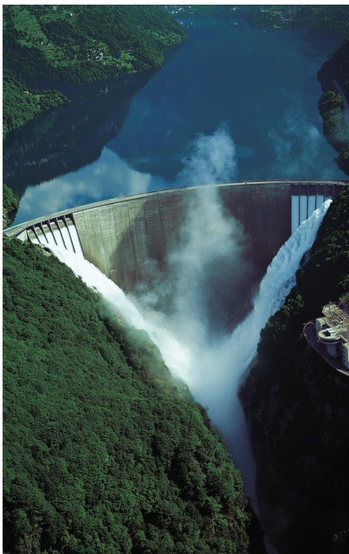
Le Barrage de Contra du val Verzasca dans le Canton du Tessin a été construit au début des années 1960 et, avec une hauteur de 220 m, il s'agit du quatrième plus haut barrage en Suisse. Deux déversoirs avec six canaux en pente chacun sont visibles des deux côtés du mur. Les déversoirs permettent une évacuation de l'eau du lac de retenue lorsque sa capacité maximale est atteinte. Photo : Swiss-COD, 2011
