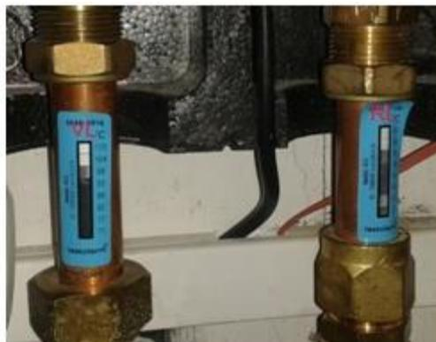
**Schéma 4:** bandes de mesure de température à l'entrée du circuit solaire (VL sur la photo) et à sa sortie (RL sur la photo). On constate une stagnation ciblée avec une température de 108°C à l'entrée du circuit solaire.
