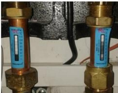
**Schéma 3:** bandes de mesure de température à l'entrée du circuit solaire (VL sur la photo) et à sa sortie (RL sur la photo). Après 4 semaines, l'entrée indique 77°C et la sortie 54°C.
