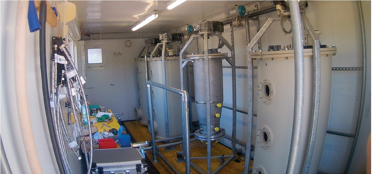
Avec cette installation située sur le site de compostage et de méthanisation Allmig à Baar (ZG), les chercheurs de la ZHAW à Wädenswil veulent prétraiter la biomasse fibreuse afin d'augmenter le rendement de biogaz. Photo : ZHAW Wädenswil
