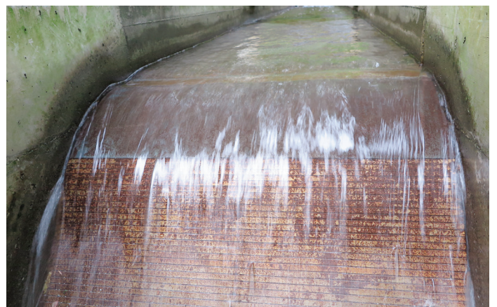
Gros plan d'une grille Coanda : Les barres métalliques horizontales agissent comme des lames de rasoir qui coupent l'eau par couches. Photo : HTW Chur
