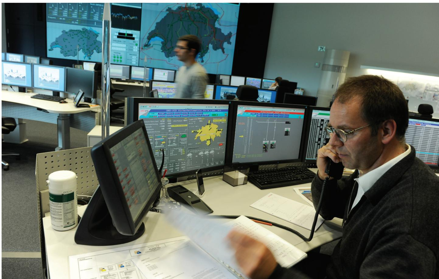
Le dispatcher du centre de contrôle de Swissgrid à Laufenburg peut exiger de l'énergie de réglage par téléphone en cas de besoin. Photo : Swissgrid
