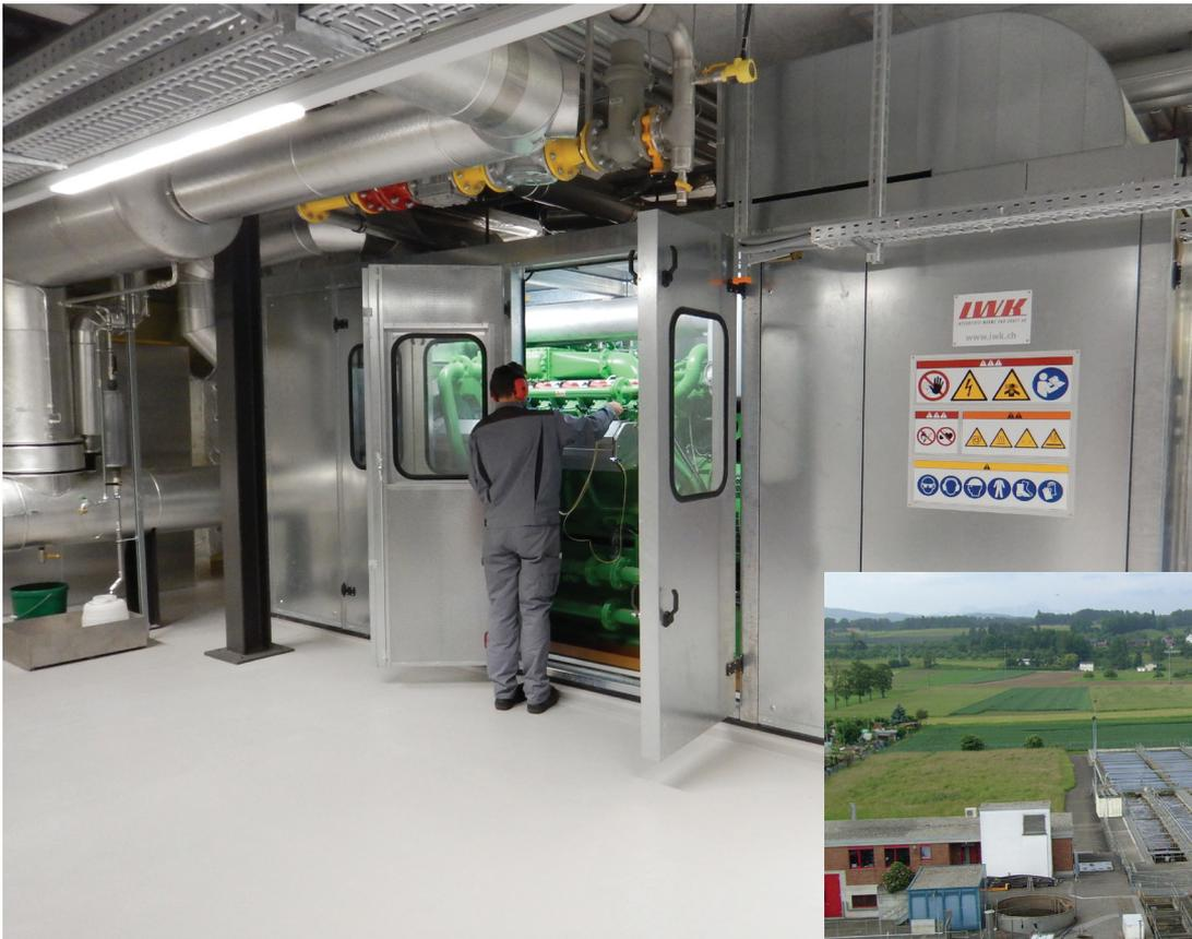
L'installation d'épuration des eaux usées (STEP) Morgental à Steinach (SG) fait partie du groupe d'énergie de réglage Alpiq. La centrale de chauffage à distance (photo à gauche) de la STEP produit de l'énergie électrique à partir du gaz de digestion. Lors Swissgrid a besoin d'énergie de réglage négatif, la puissance de la centrale de chauffage à distance est réduite pour quelques minutes ou heures. Photo : STEP Morgental
