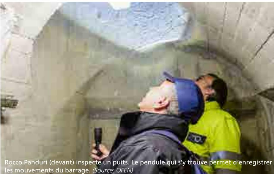
Rocco Panduri (devant) inspecte un puits. Le pendule qui s'y trouve permet d'enregistrer les mouvements du barrage. (Source: OFEN)
