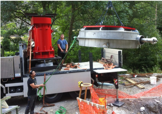
Livraison de la turbine et de l'alternateur sur le site de la PCH du Pied du Mont (source: Gasa Hydro SA)
