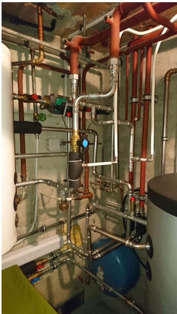
Schéma 1: Conduites de chauffage et d'eau chaude non isolées
